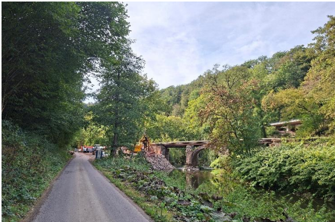
Querung der Kyll durch die Bahntrasse
