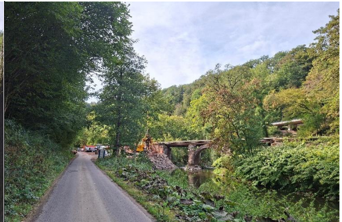
Abschnitt oberhalb der Bahnstreckenüberführung
