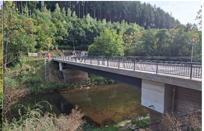
Blick auf die instandgesetzte Moltkeburg Brücke
