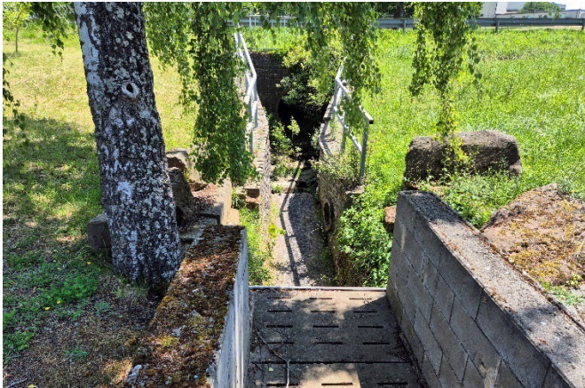
Vorne Einlass in die Verrohrung, hinten Durchlass in L 46
