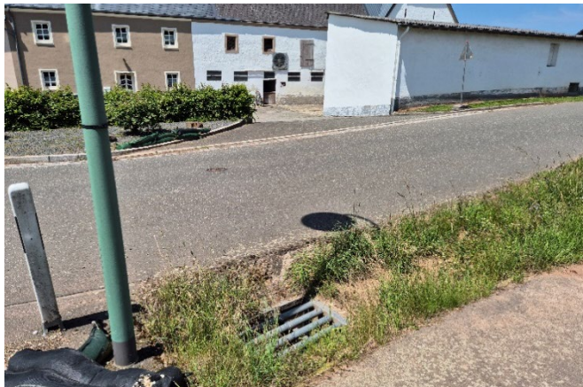
Einlass und betroffenes Objekt an der Burgstraße
