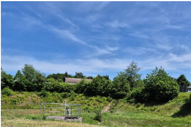
Rückhaltebecken im Gelände der AirBase
