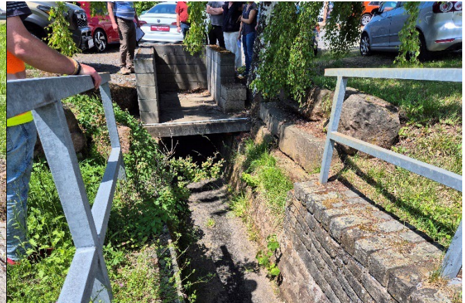
Blick auf das Einlassbauwerk vor der Bachverrohrung
