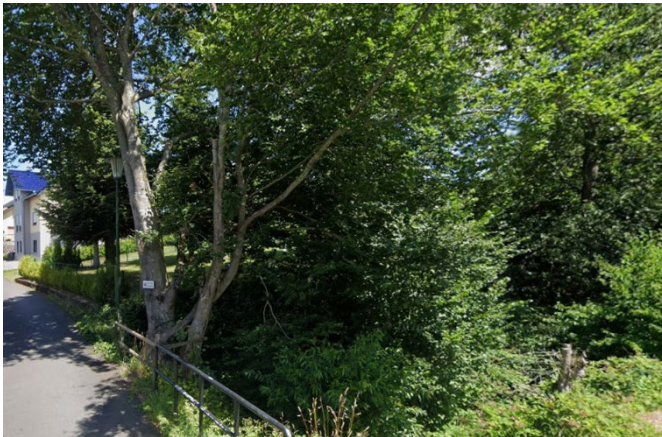
Einlassbereich am Straßendurchlass der Schulstraße
