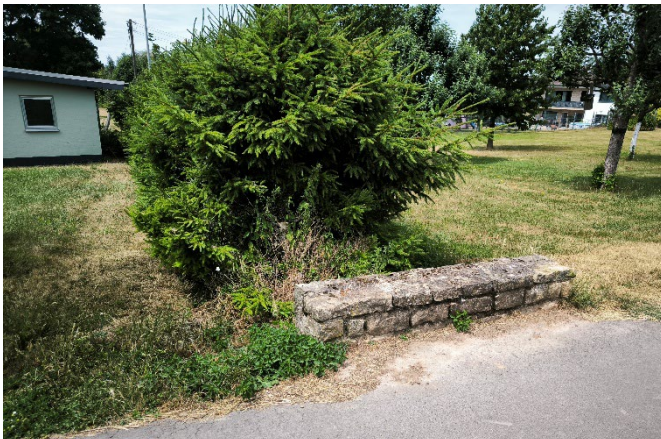
Wegedurchlass, Blick nach Westen zum Sportplatzgelände
