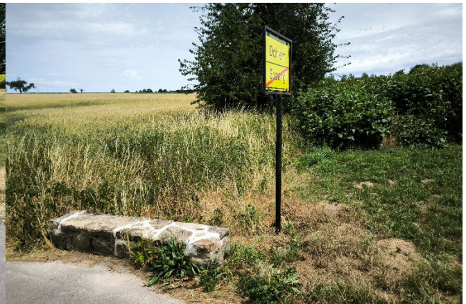
Wegedurchlass, Blick nach Osten; Quellbereich d. Baches
