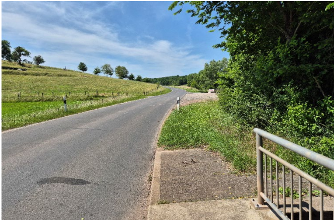
Blick entlang der K 91 zur Einfahrt
