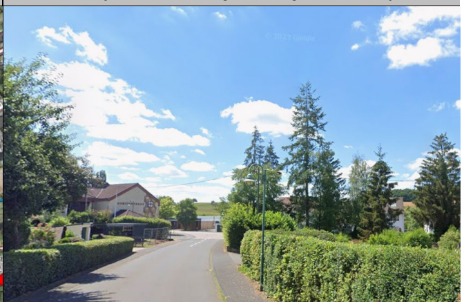
Potenziell abflusskritische Lage entlang der Neustraße
