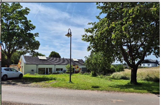
Kindergarten unterhalb des Bachdurchlasses
