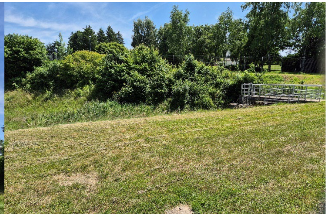
Mönchbauwerk im Rückhaltebecken
