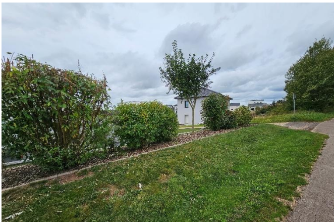
Entwässerung entlang des Neubaugebietes „Am Ringweg“
