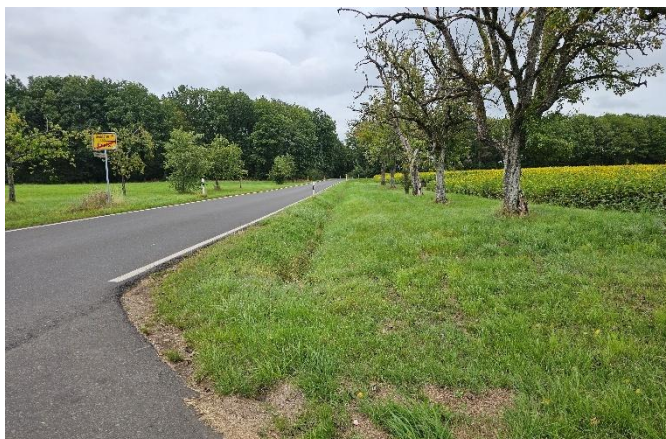
Grabenentwässerung entlang d. K 37, Blick nach Osten
