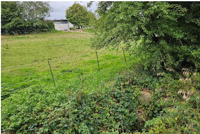
Einlass in die Bachverrohrung des Heiligenbaches
