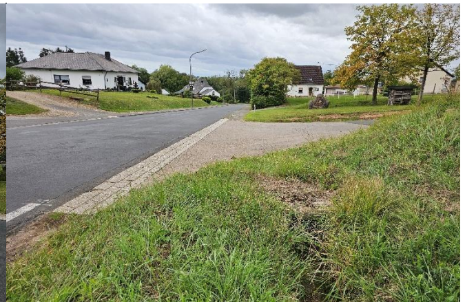
Straßenseitige Grabenentwässerung, Blick nach Süden
