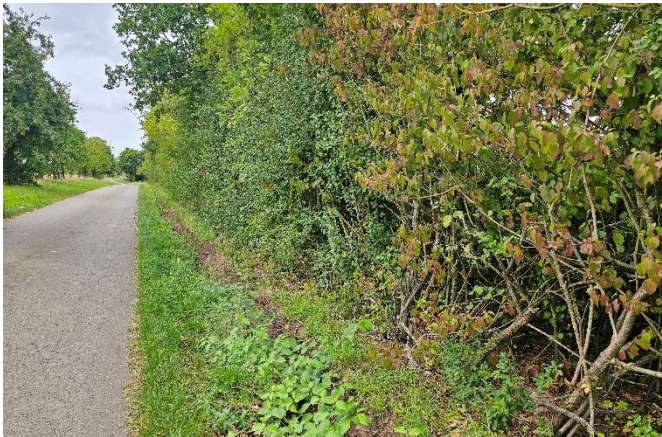
Linksseitiger Grabenabschnitt, Blick nach Norden
