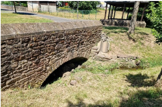
Brückenbauwerk, Blick nach Norden
