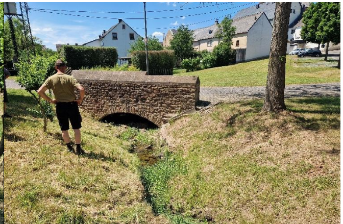
Blick in Fließrichtung nach Westen
