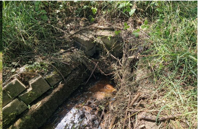
Wegedurchlass unterhalb, Blick in Fließrichtung
