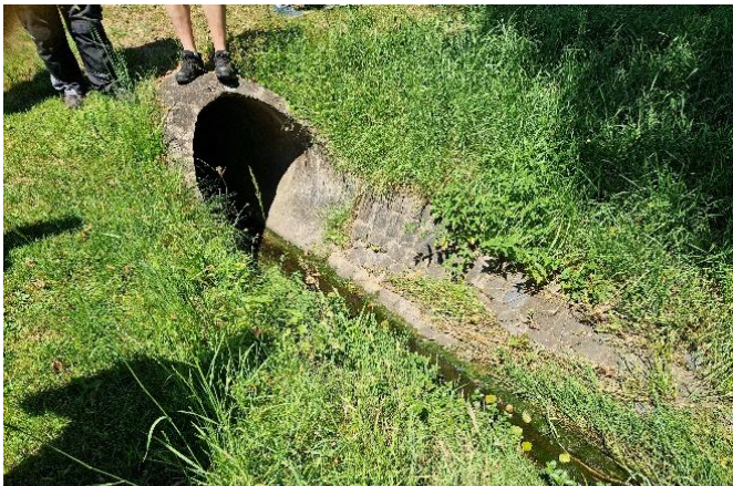
Verrohrung an Landstraße: Einlass
