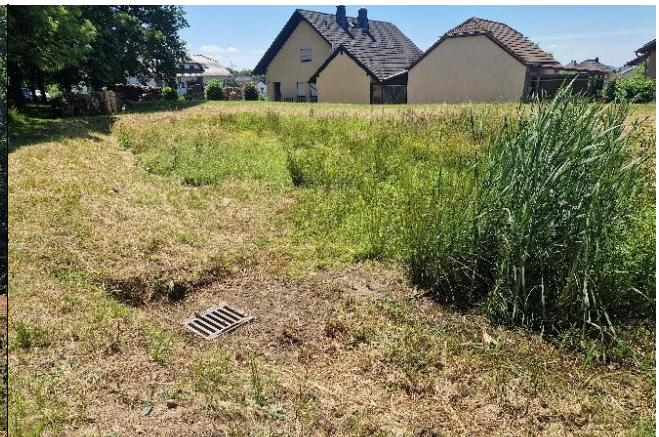
Einlassbauwerk an RRB; Damm vor der Bebauung
