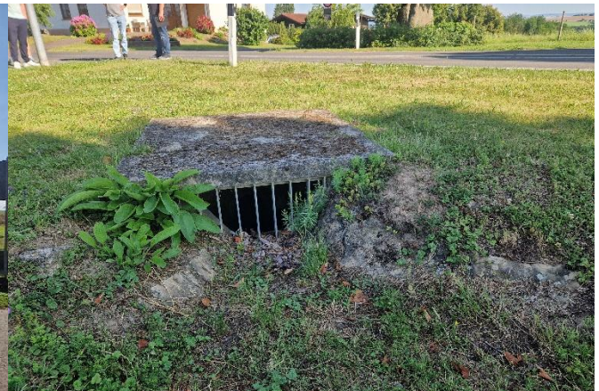
Blick Richtung Norden auf das Einlassbauwerk
