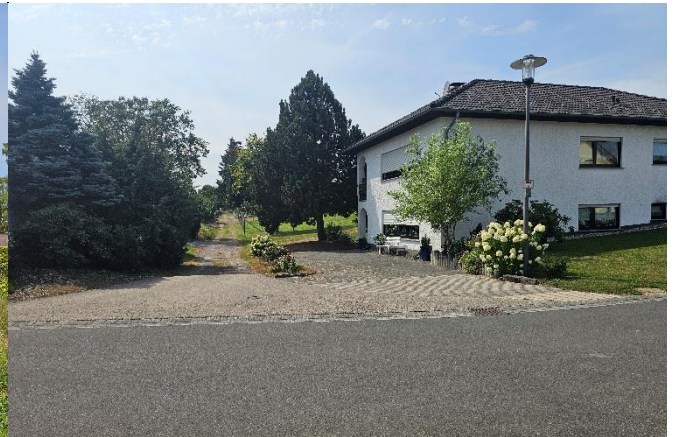
Johannesstr., Einstaubereich im Umfeld Johannesstr. 1
