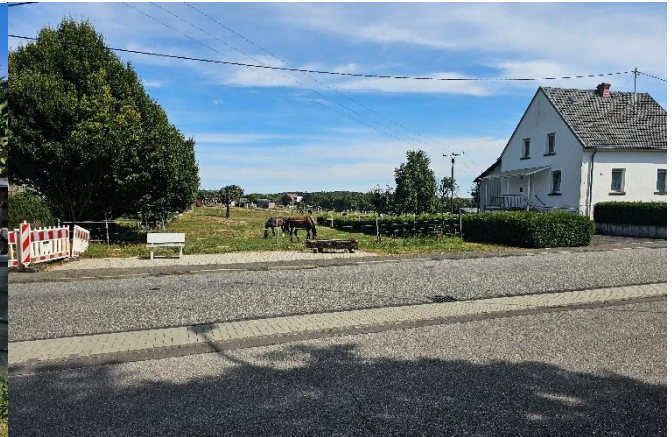
Bereich der verrohrten Außengebietsentwässerung
