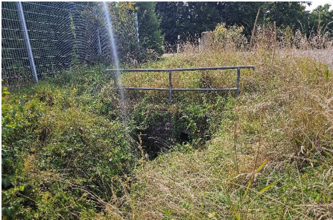
Abschnitt Auslassbereich, östlich der Kreisstraße
