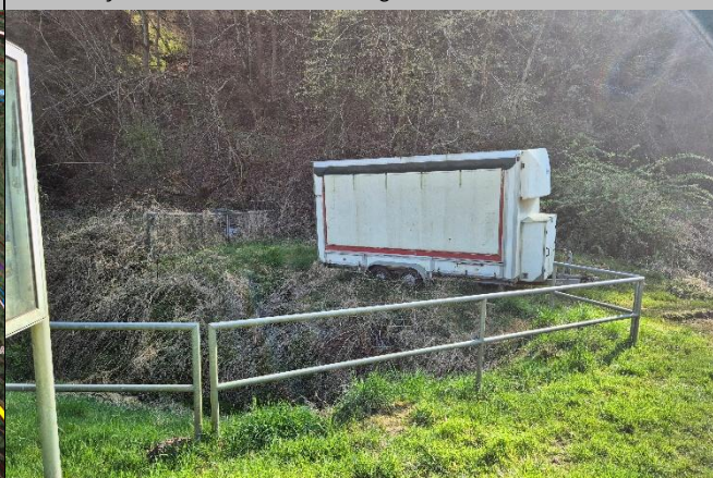
Blick auf Einlassbereich am Wegedurchlass
