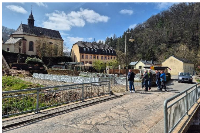
Blick auf Bachdurchlass am Friedhof (Bildmitte links)
