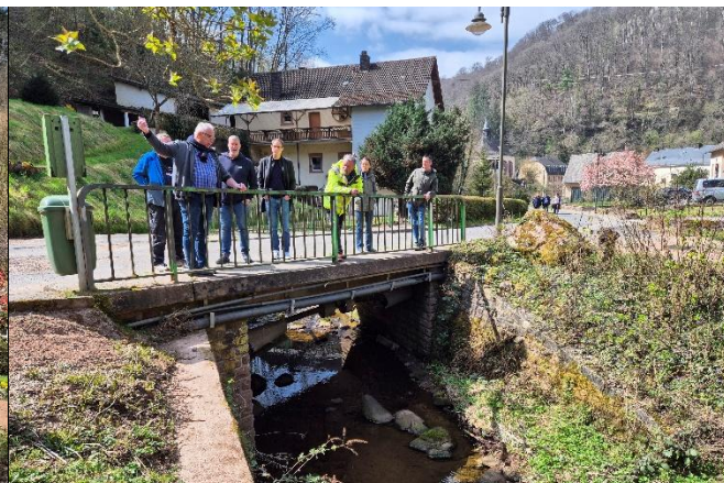
Durchlass Rotlaystraße in Fließrichtung
