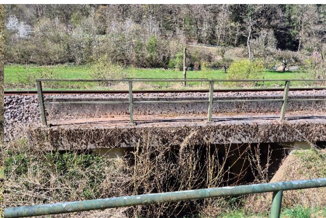
Durchlass zur Kyll in der Bahntrasse: Dautenbacher Weg
