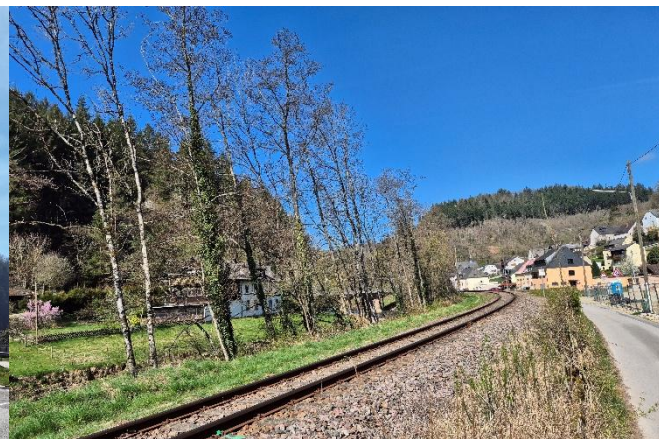
Straßendamm zwischen Daufenbacher Weg und Kyll
