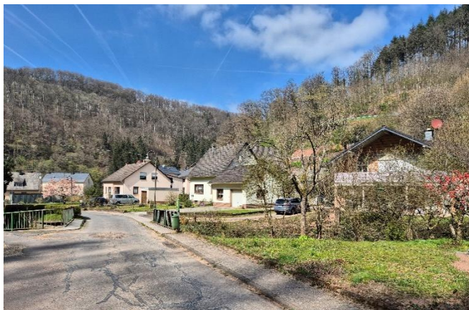
Rotlaystr. und Bachdurchlass (Bildmitte), Blick in Fließrtg.
