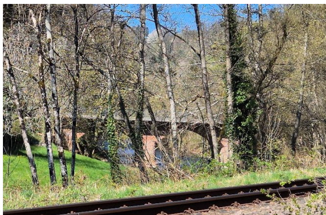
Blick auf Mehrfelderbrücke an der Kyll
