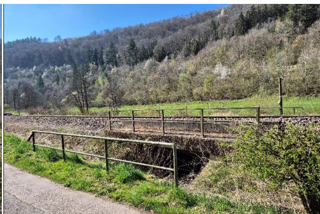
Durchlass am westl. daran angrenzenden Bahndamm
