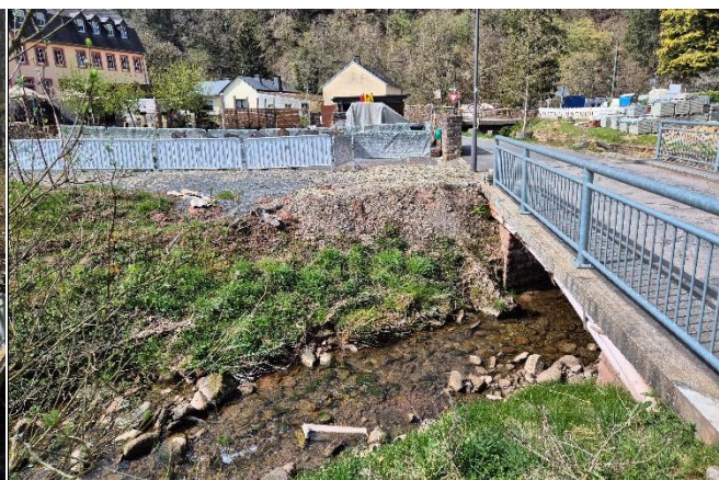
Gewässer vor dem Durchlass, Friedhof hinten
