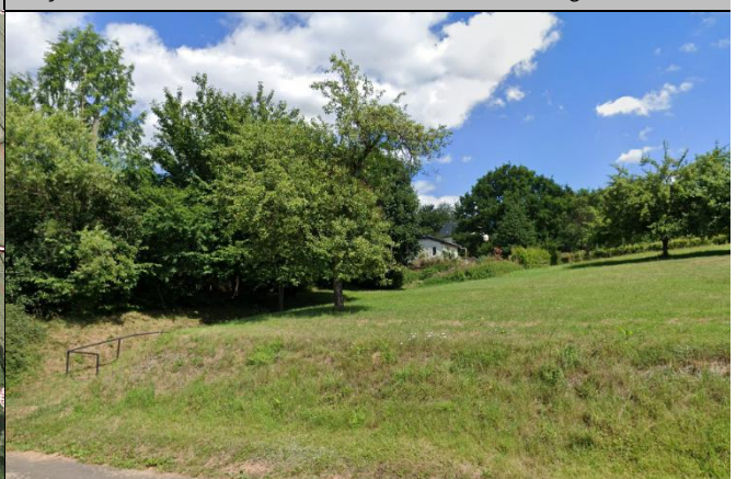
Abflusskritische Flächen nördlich der Verrohrung
