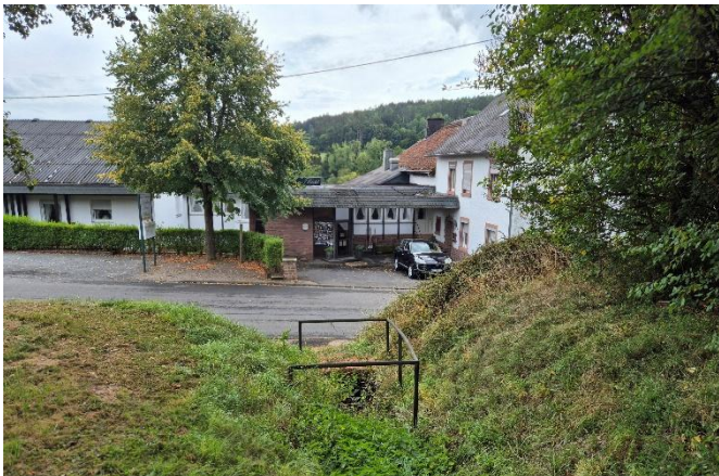
Blick in Fließrtg.: Einlass in die Verrohrung
