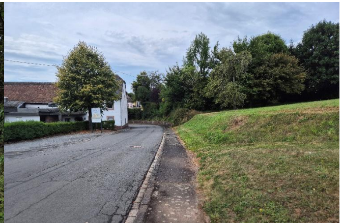
Abflusskritischer Straßenabschnitt im Überlastungsfall
