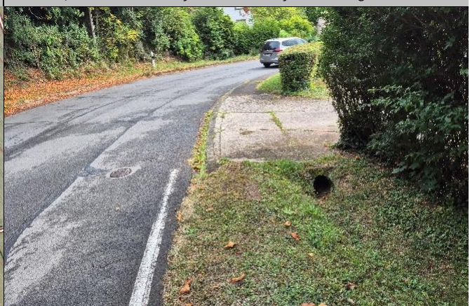
Private, verrohrte Überfahrt am Straßenseitengraben
