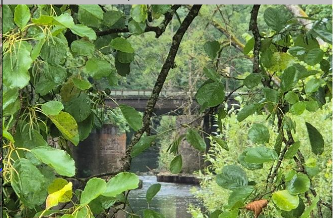
Bahnbrücke über die Kyll
