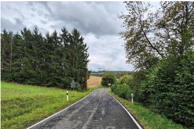
Blick auf verrohrten Gewässerabschnitt
