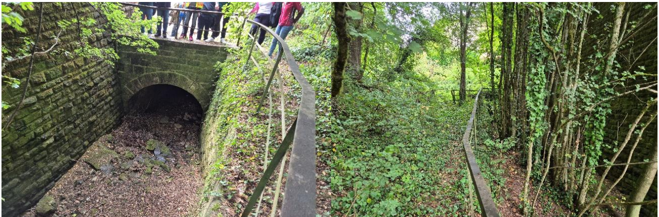
Einlassbauwerk des Durchlasses vor Straße und Bahntrasse
