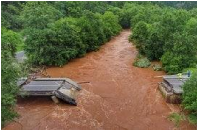
Zerstörte Brücke in Speicher (Foto: dpa Bildfunk S. Schmitt)
