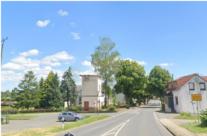
Lindenstr.: Blick auf eingestaute Senke oberhalb d. FW
