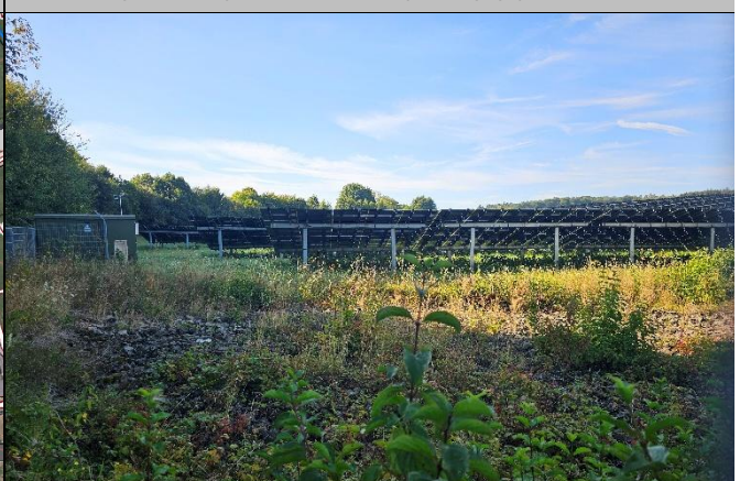
Solaranlage mit Trafostation im überflutungsgefährdeten Bereich
