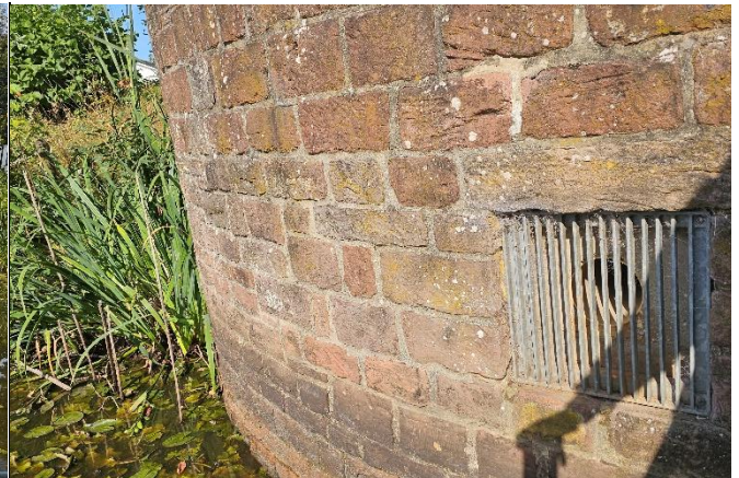
Überlaufschacht mit Rechen innerhalb der Weiheranlage
