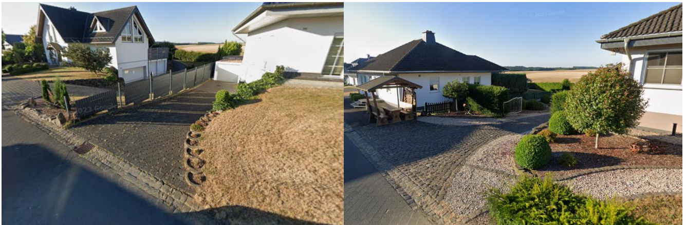
Einstaugefährdete Bereiche an den Gebäuden Nr. 9 und 11
