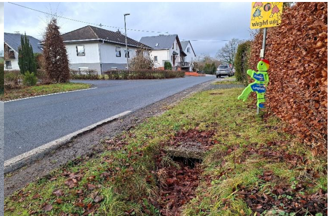
Einlassbauwerk am Straßengraben (rechts)
