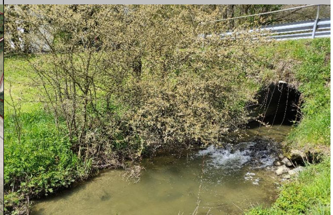
Auslass des Durchlassbauwerkes v. Litzbach
