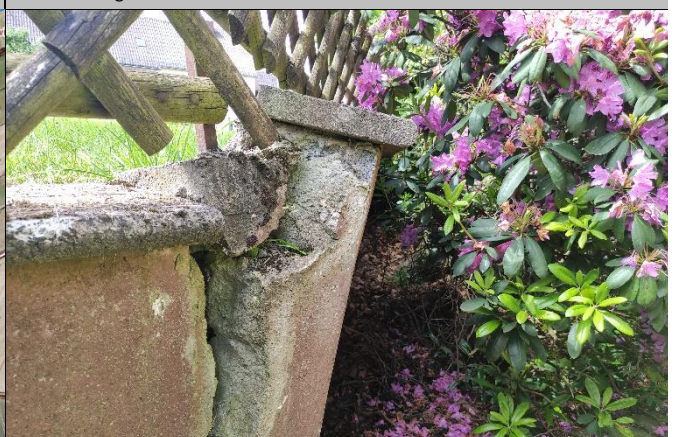
Beschädigtes Mauerwerk
