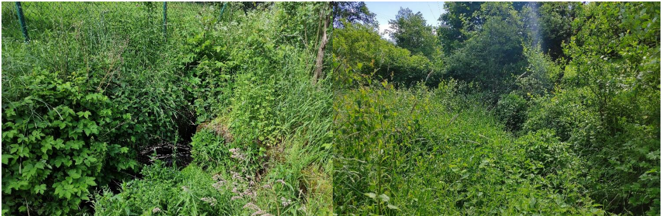
Blick auf das Einlassbauwerk
