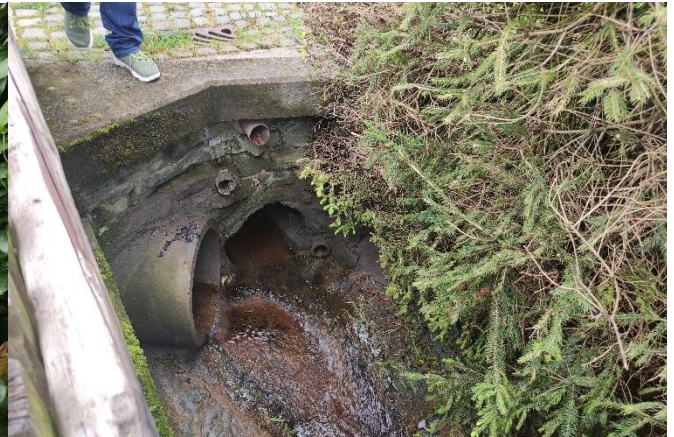
Auslass in den Straßenbereich „Auf der Rüttsch“
