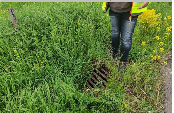
Einlassbauwerk, westlich von Ackerweg 7
