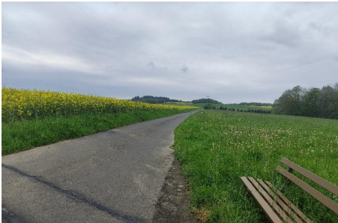
Verlängerung des Straßenkörpers „Brehmacker“
