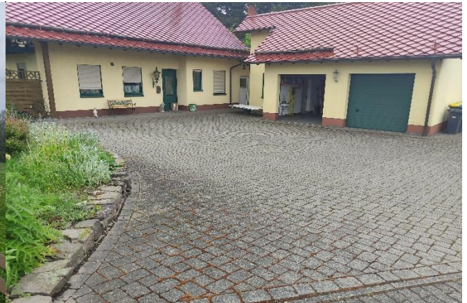
Gefährdetes Objekt „Brehmacker 27“
