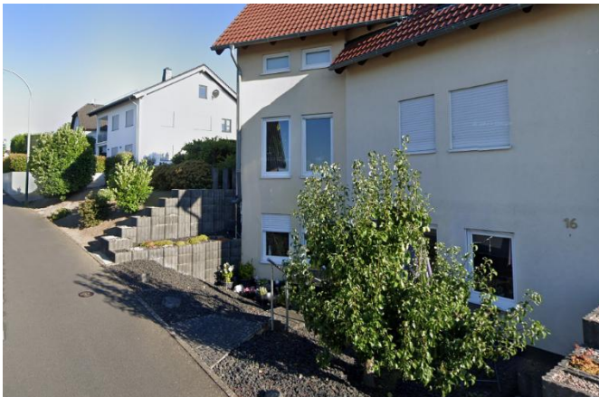
Brühlbachstr.: abflusskritischer Straßenabschnitt (bsp.)
