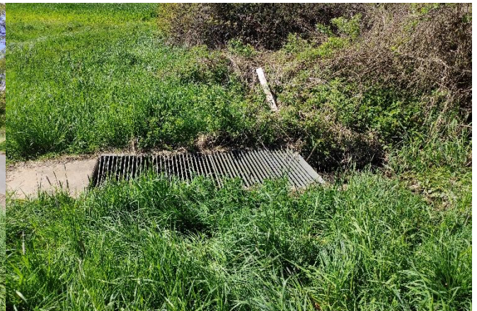
Einlassbauwerk am Graben oberhalb der Bebauung
