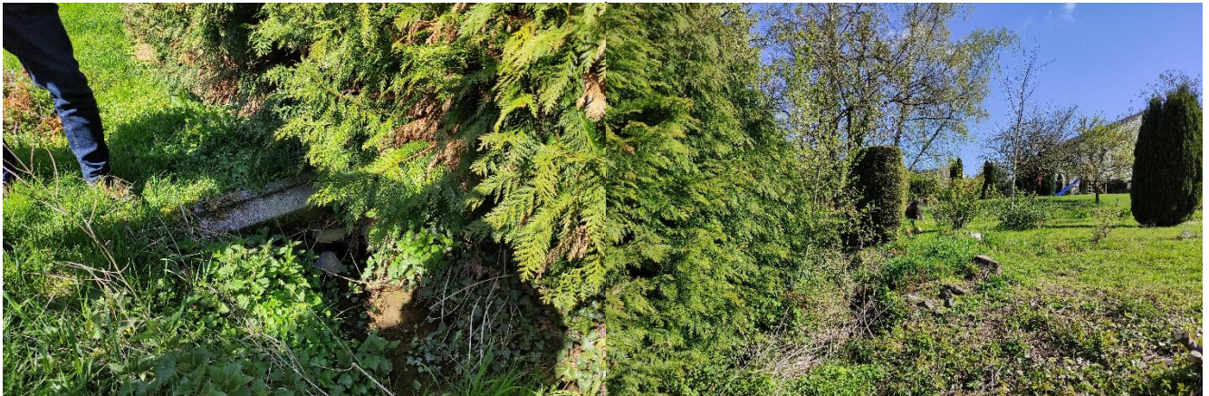
Verrohrung zum Brühlbach auf Grundstück d. Poststraße
