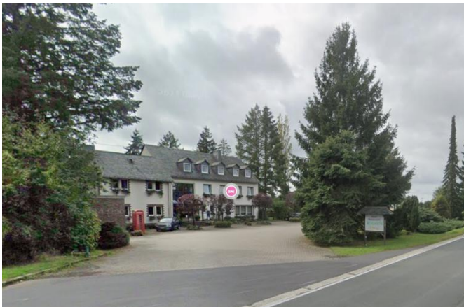
Zufahrt zum Hotel von der B 259 (Fotos: Google Streetview)
