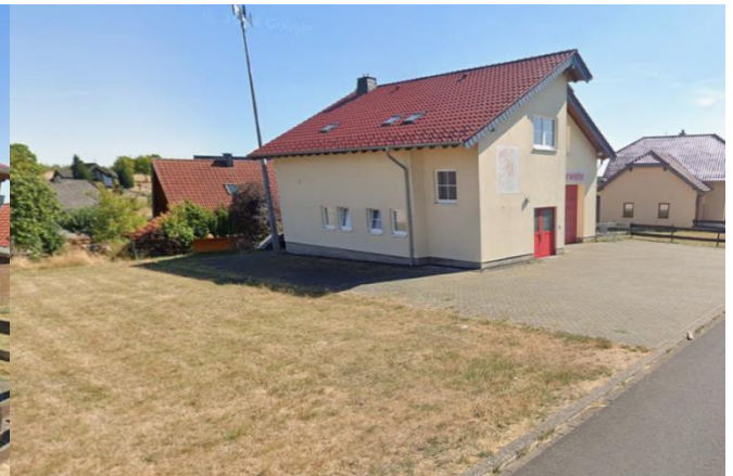
Potenzieller Abflussbereich nördlich des Gebäudes
