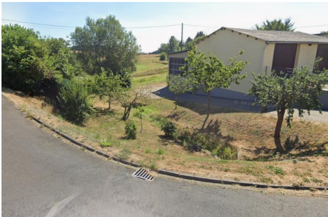
Auslassbereich der Verrohrung (r.) und Überfahrt unterhalb
