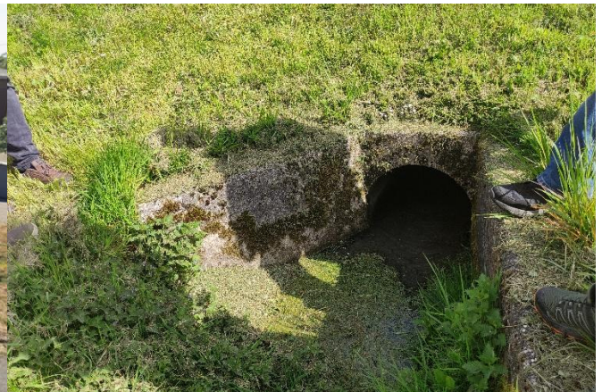
Rohrauslass der Bachverrohrung unterhalb der Straße
