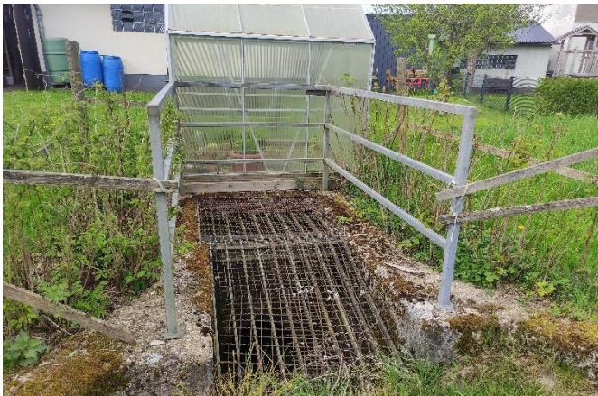
Blick auf Einlassbauwerk hinter dem Gebäude Talstraße 1
