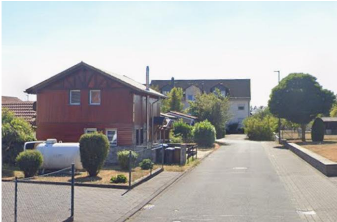
Im Oberflur, Bereich Grundstück Nr. 19
