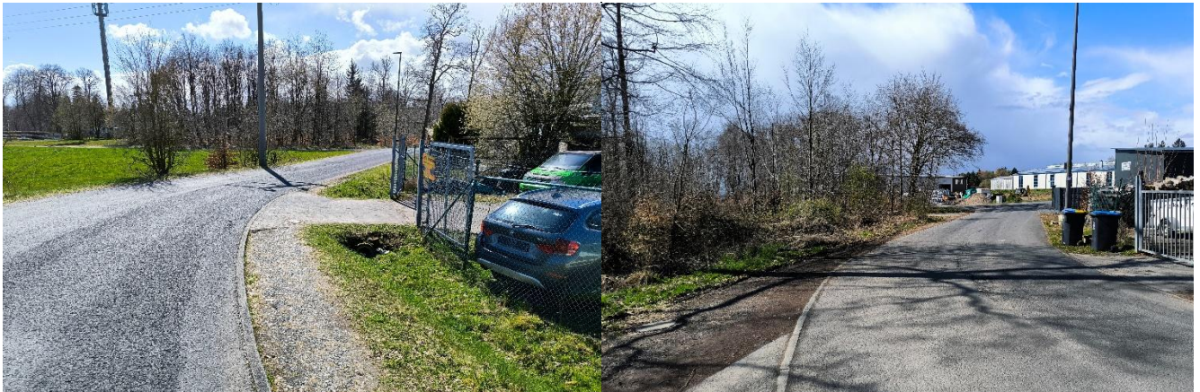
Graben und Rohrdurchlass am Grundstück „Am Seitert 1“
