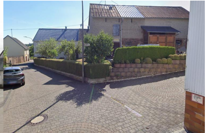
Kirchstr./ Im Winkel (l.): Abfluss wegen überlasteter Rinne
