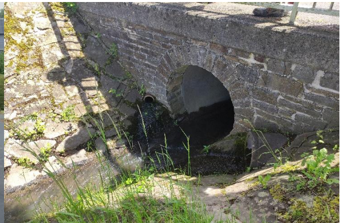
Auslass des Straßendurchlasses Schulstraße
