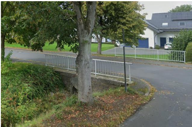
Blick in Fließrtg. auf den Durchlass in der Schulstraße
