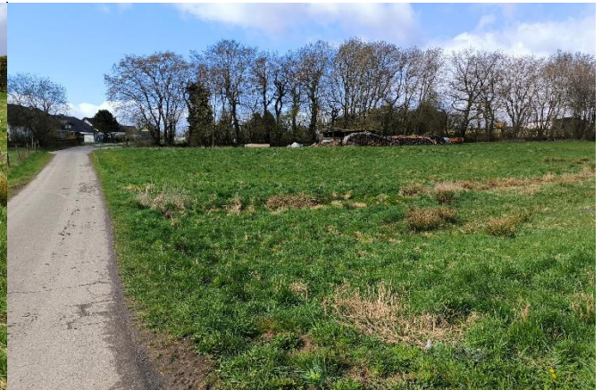
Wegedurchlass, Blick zur Gartenstraße, Fließrtg. v.l.n.r.
