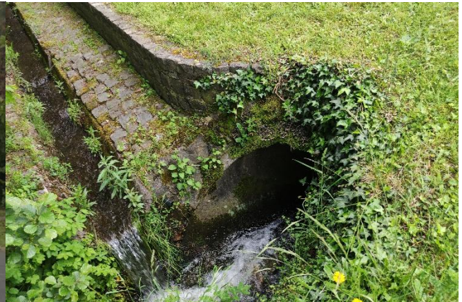
Einlass der Verrohrung Brunnenstr.; Seitengewässer v. links
