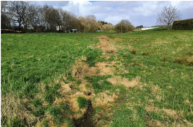
Bach am Wegedurchlass: Blick gegen die Fließrichtung
