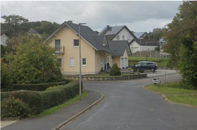
Kreuzungsbereich über Bachdurchlass (Fließrtg. v.r.n.l.)
