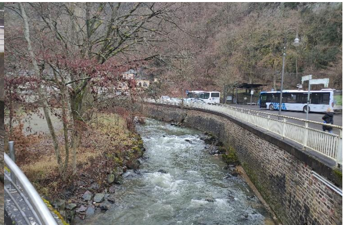
Blickrichtung Westen entgegengesetzt der Fließrichtung
