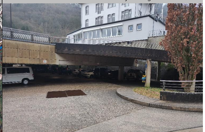
Bereich unteres Parkdeck mit Wasserführung unterhalb
