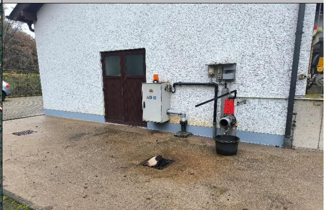
Zugang zu Wartungsräumen mit Luke zum Keller
