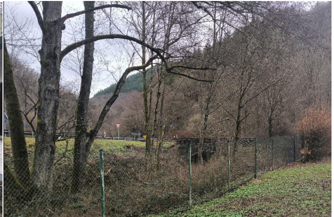
Erdenbach und Brückenbauwerk der L 103
