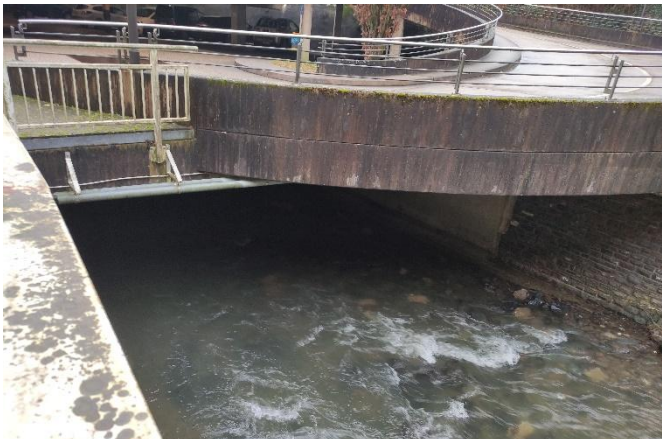
Blick auf Einlass des Parkhauses
