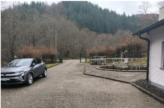
Geländezufahrt mit Notfallwasserpumpe im Hintergrund
