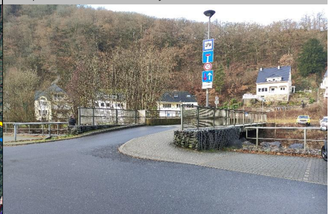
Parkplatzbrücke über den Ueßbach
