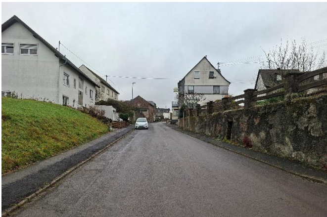
Moselblickstraße, Blick gegen die Fließrichtung
