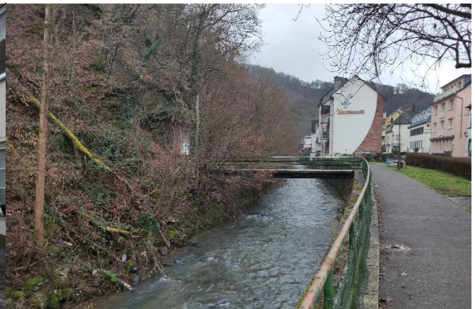
Ueßbach zwischen Felsen und Bebauung Kurfürstenstraße
