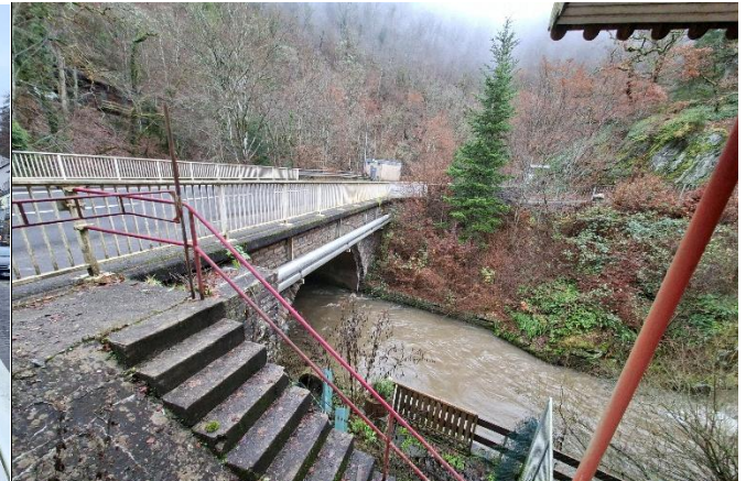
Ueßbach-Brücke der L 103 (Kurfürstenstr. 1 (Elfenmühle))
