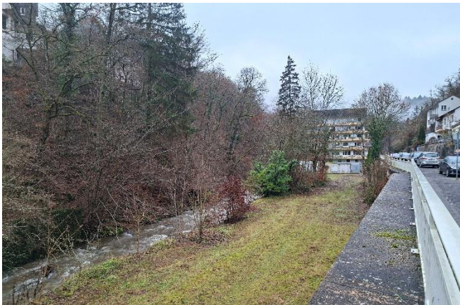
Böschungsbewuchs hinter der Kurfürstenstraße
