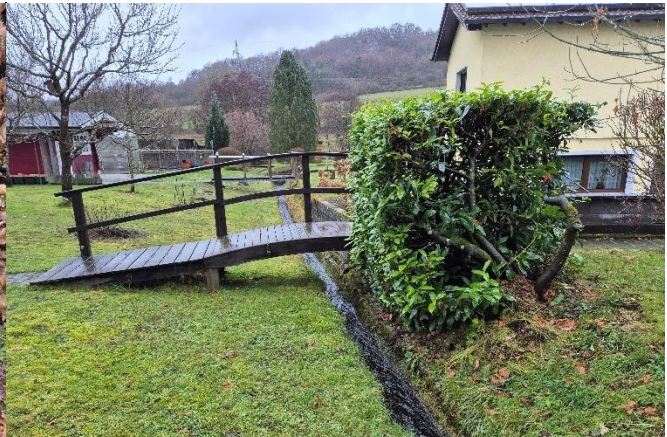
Private Brücken über gestrecktem Verlauf, Blick in Fließrtg.
