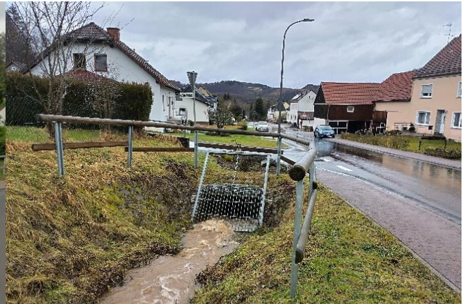
Einlass in die Verrohrung vor der Zufahrt zum Sportplatz
