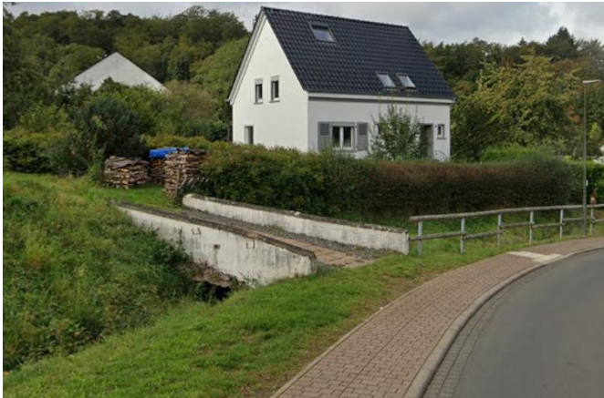
Zufahrt über den Bach zu Haus Geeser Straße 26
