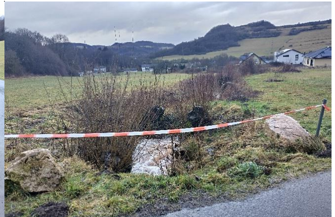
Auslassbereich, Blick in Fließrichtung zur Bebauung
