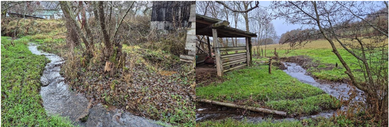
Dreisbach Unterlauf entlang der linksseitigen Scheune
