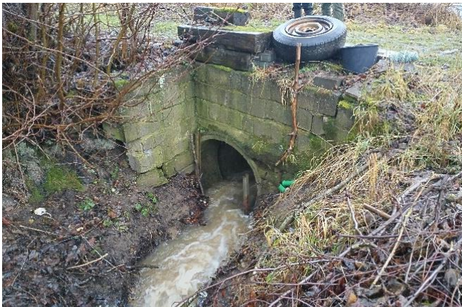
Durchlass oberhalb der Geeser Straße
