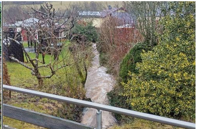
Gewässer unterhalb der Geeser Str., Blick in Fließrichtung
