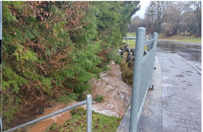
Bach unterhalb der Brücke der K 33, Blick in Fließrtg.
