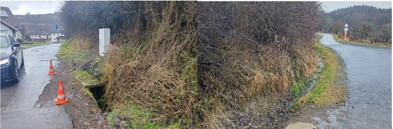
Einlassbauwerk an der Kirchstraße
