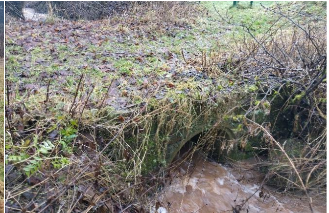
Private Verrohrung im Flurbereich
