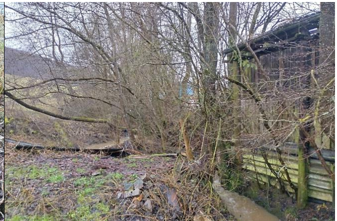
Bebauung linksseitig und Schutt rechtsseitig des Baches
