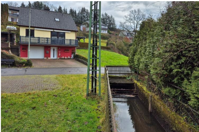
Einlassbauwerk der Bachüberbauung vor der Bachstraße
