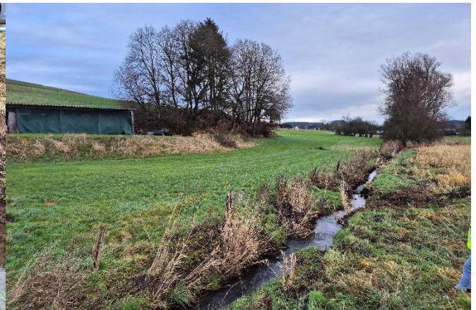
Fließabschnitt Mühlenweg bis Hauptstr., Blick in Fließrtg.
