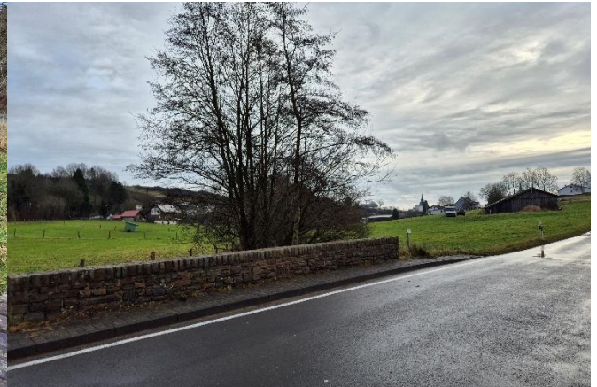
L 24 über dem Tieferbach, Blick in Fließrichtung
