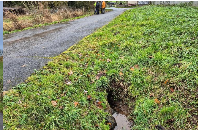
Durchlass im Weg, Graben verschwenkt auf andere Seite
