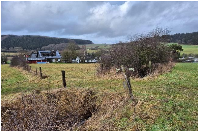
Wegedurchlass des Grabens oberhalb „Zur Auelsley 15“
