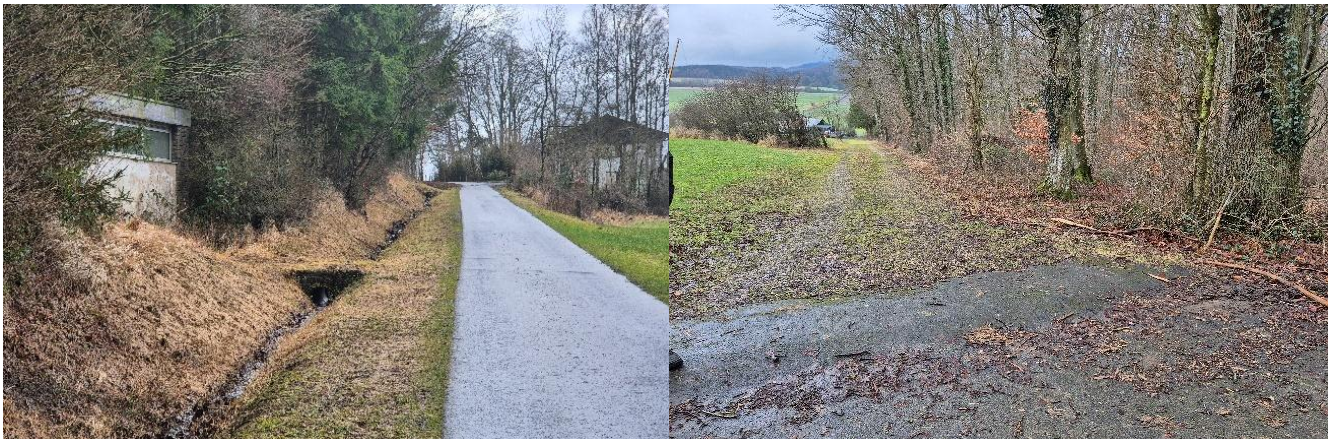
Graben zur Außengebietsentwässerung, Blick gg. Fließrtg.
