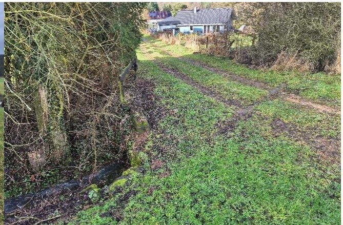
Wegedurchlass des Grabens oberhalb „Zur Auelsley 9“
