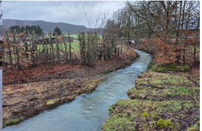
Blick in Fließrichtung der Straßenbrücke
