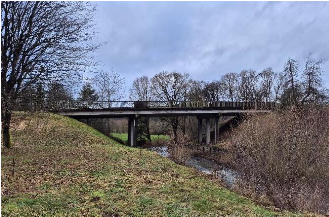
Amselweg-Brücke über den Oosbach (Blick gg. Fließrtg.)
