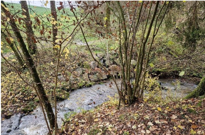
(N) Scheuernerbach mit Erosionsschutzsteinen
