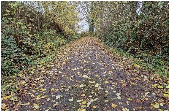
(W) „Rundweg 13“: Blick gegen Fließrichtung
