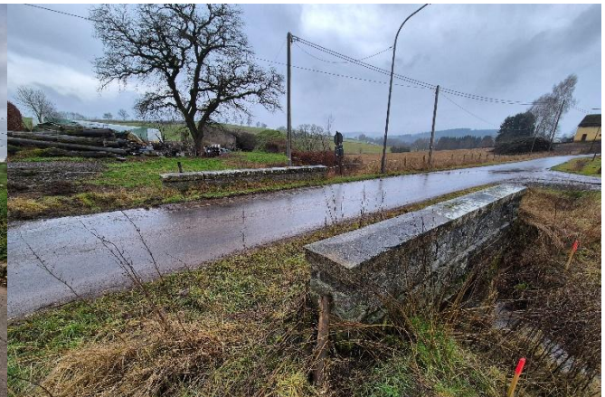
(S) Blick auf das Brückenbauwerk am Fricksbach
