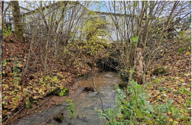
(N) Auslass d. Bachverrohrung unterhalb d. JOLEKA GmbH
