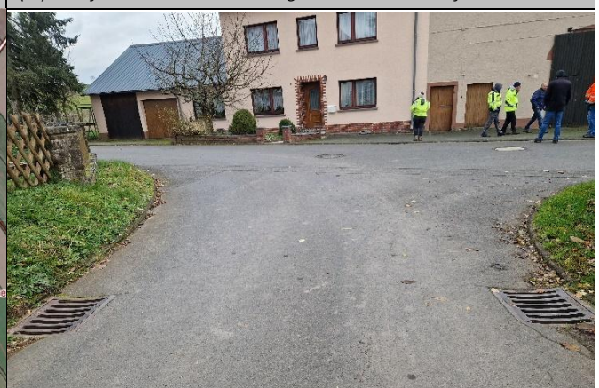
(O) Straßeneinlässe beidseitig vor Brunnenstraße 1
