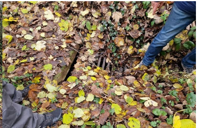
Einlassbauwerk am Rundweg (rechtsseitig i. Fließrichtung)
