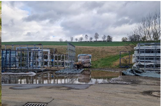
(O) Blick auf den Lagerplatz und „Am Rotherberg“
