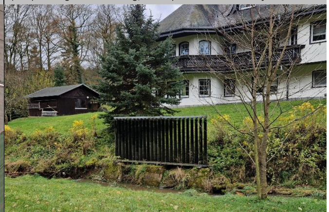
(SW) Anlieger Birkenweg, Heizspiralen am Bachufer
