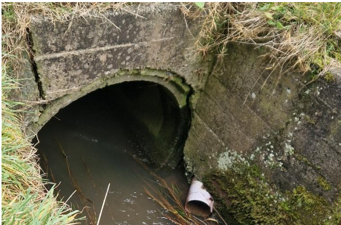
(S) Einlass in die Verrohrung des Fricksbachs (Fa. JOLEKA)
