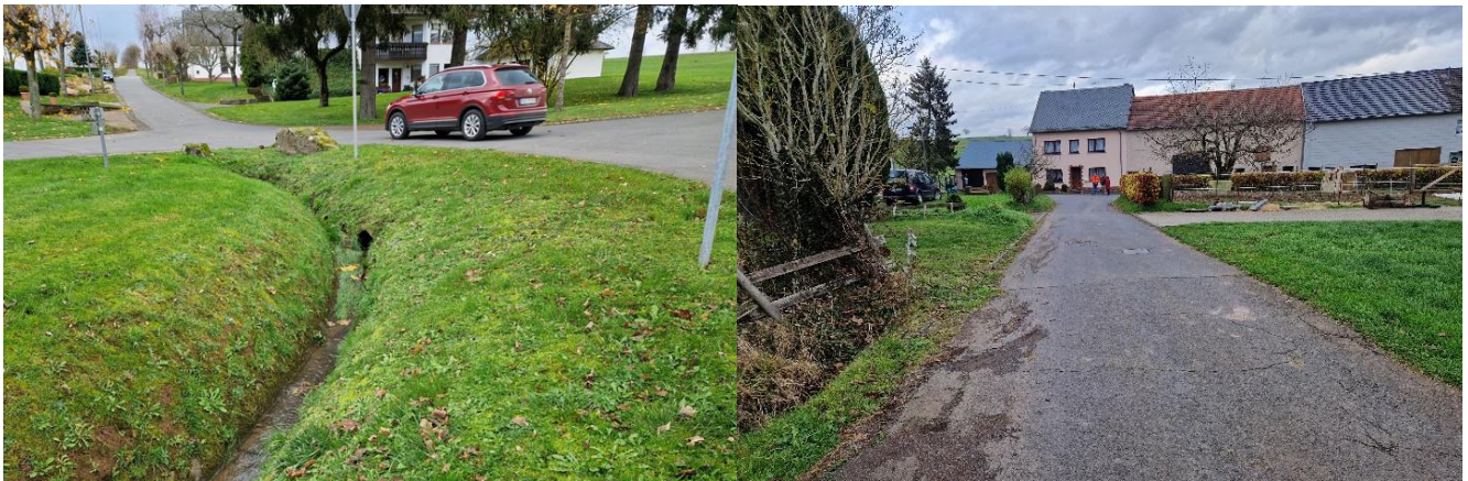
(NW) Brunnenstr./„In der Spann“. Vorne Verrohrung zur
