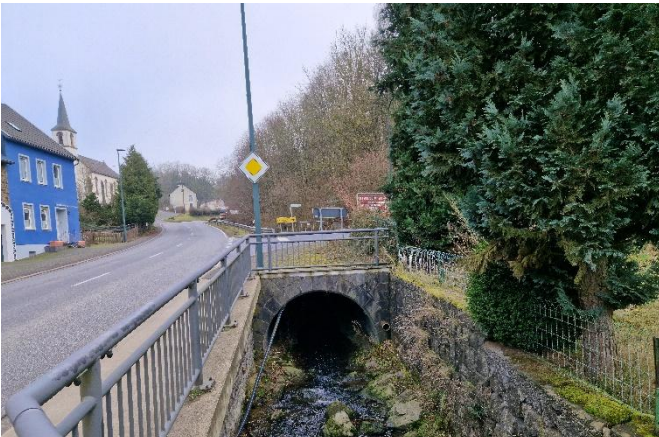
(O) Blick auf den Straßendurchlass der Bahnhofsstraße
