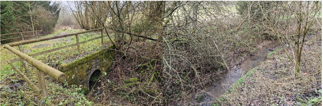
(SW) Blick auf den Wegedurchlass und den Wirtschaftsweg
