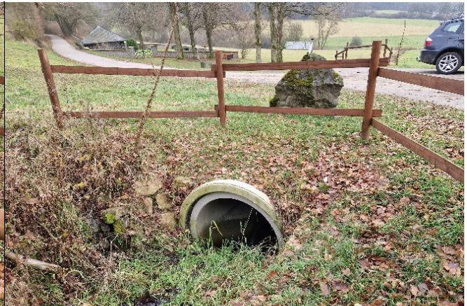
(S) Blick auf Durchlass und Trauerhalle (Hintergrund)
