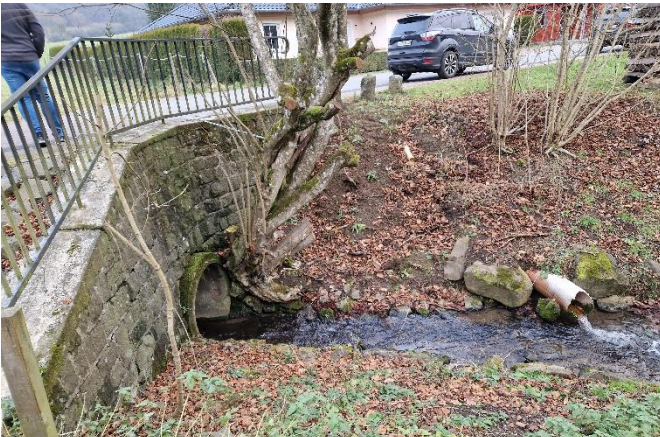
(O) Südseite d. Straßendurchlasses mit Baum am Auslass
