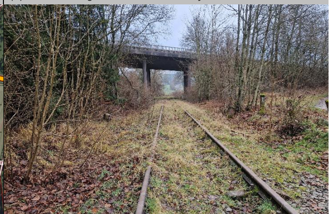
(S) Blick entlang des Bahndamms auf die B 410
