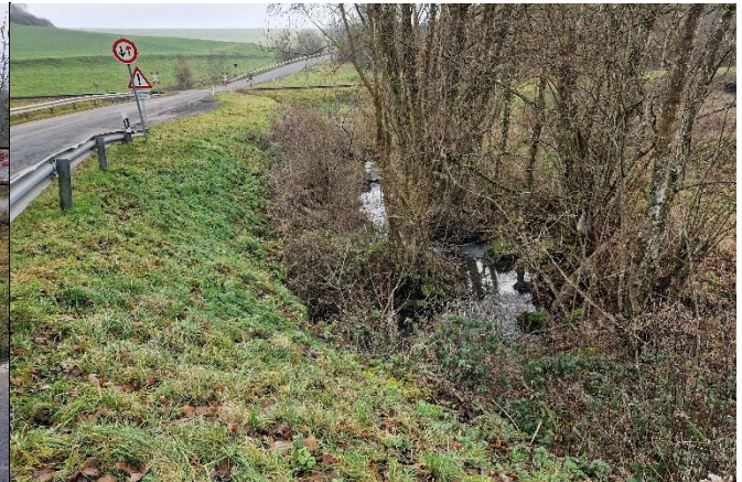
(S) Blick auf den Auslass der Verrohrung an der K 35
