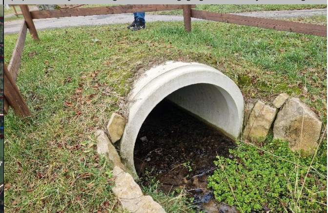
(N) Blick auf die Wegeverrohrung gegen die Fließrichtung
