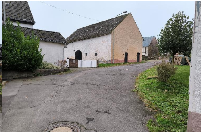
Südlicher Verlauf des Straßenkörpers „Im Unterdorf“
