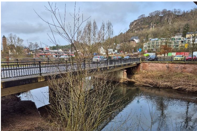
Brücke der Bahnhofstraße über die Kyll
