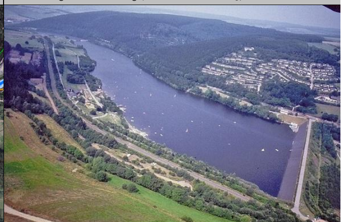
Stauanlage Kronenburg (Foto: ASV Kronenburg)
