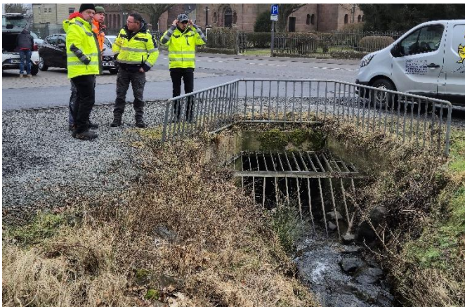
Einlassbauwerk in die Verrohrung vor der B 410
