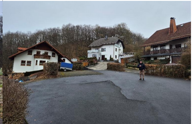
Bebauung in der Tiefenlinie (Bereich Nr. 25-29)
