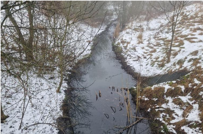
Blick vom Auslass der Verrohrung nach Westen zum RHB
