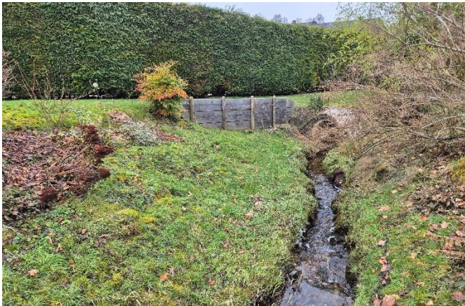
Einlass in die Verrohrung auf dem Privatgrundstück
