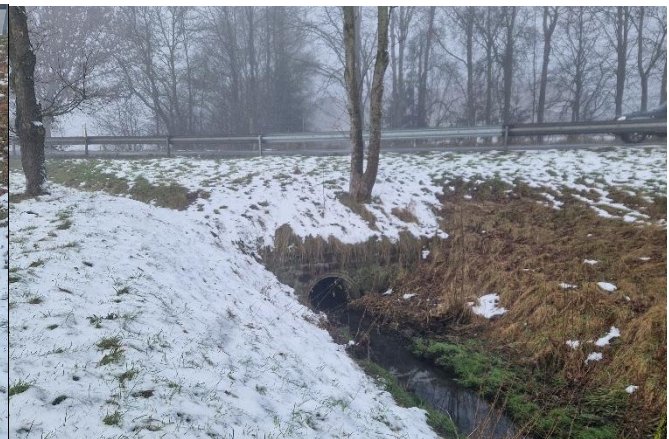
Peschenbach-Durchlass in der L 29, Blick in Fließrichtung
