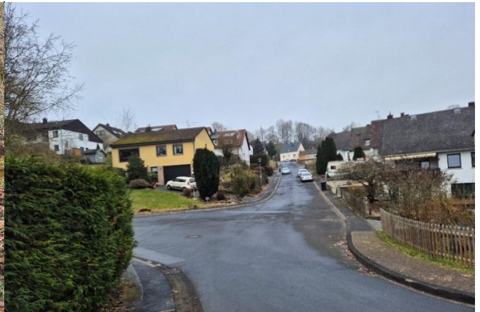
Kreuzungsbereich über der Bachverrohrung
