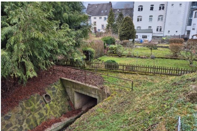
Einlass in das Bauwerk oberhalb der Arbeitsagentur
