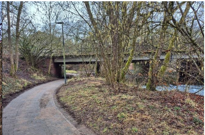
Blick entlang des Weges gegen die Fließrichtung zur Brücke
