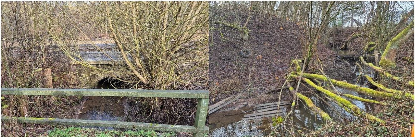
Blick vom Weg in Fließrtg. auf den Durchlass im Bahndamm
