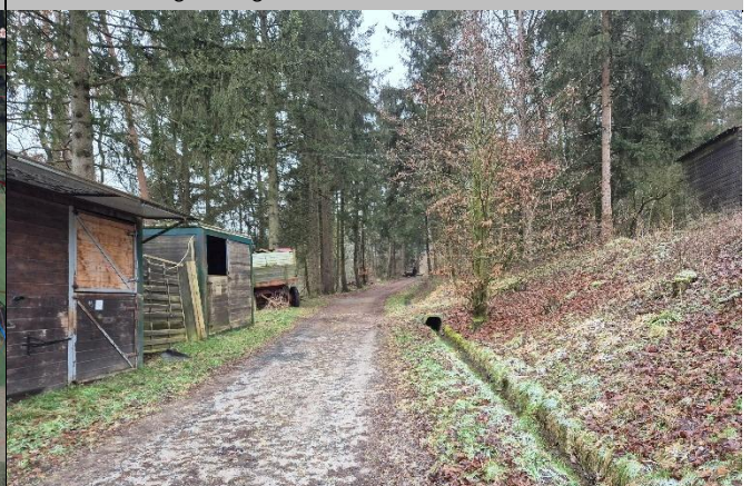
Entwässerungsanlagen oberhalb der Reithalle
