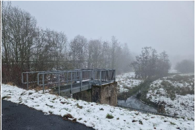
Mönchbauwerk im Rückhaltebecken am Vulkanring
