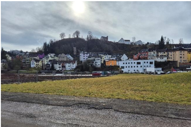
Fläche des Sternparks zu Beginn der Bauarbeiten
