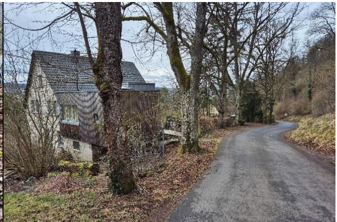
Straßenabschnitt über der Verrohrung
