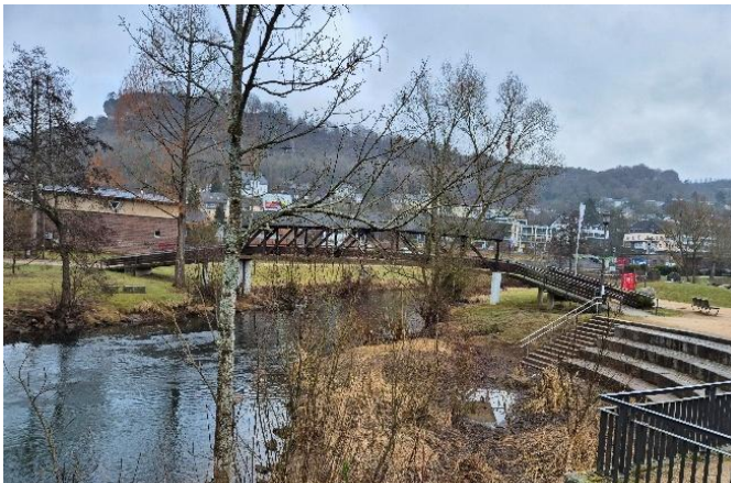
Blick gegen die Fließrichtung auf die Fußgängerbrücke
