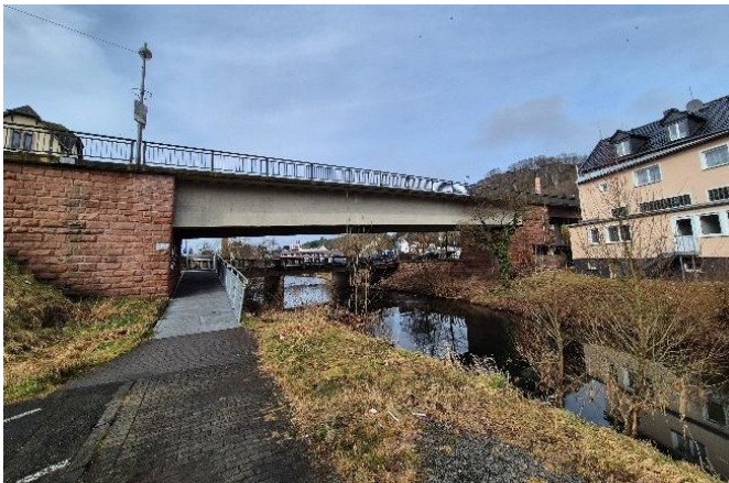
Blick in Fließrichtung der Kyll auf die Hochbrücke
