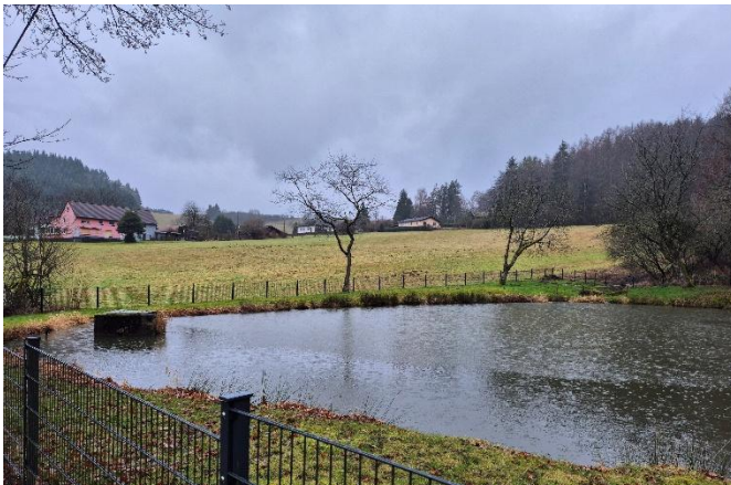
Weiher mit Mönchbauwerk im Hauptschluss des Baches
