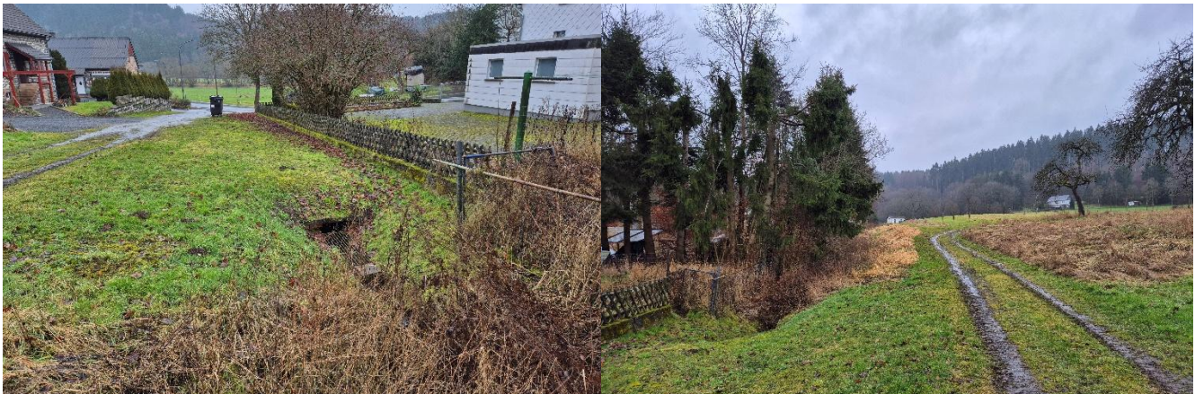
Einlassbauwerk Bachverrohrung Ortsgraben
