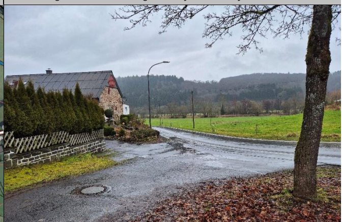
Kreuzungsbereich Bewinger Straße: Notabfluss in Wiesen
