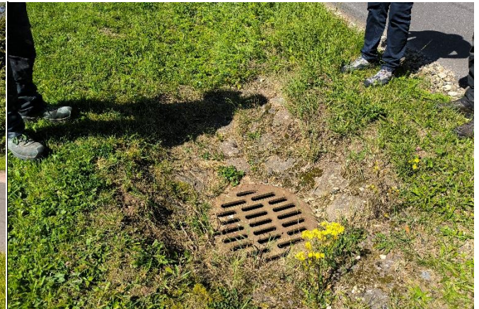
Einlassbauwerk auf der Südseite des Straßenkörpers
