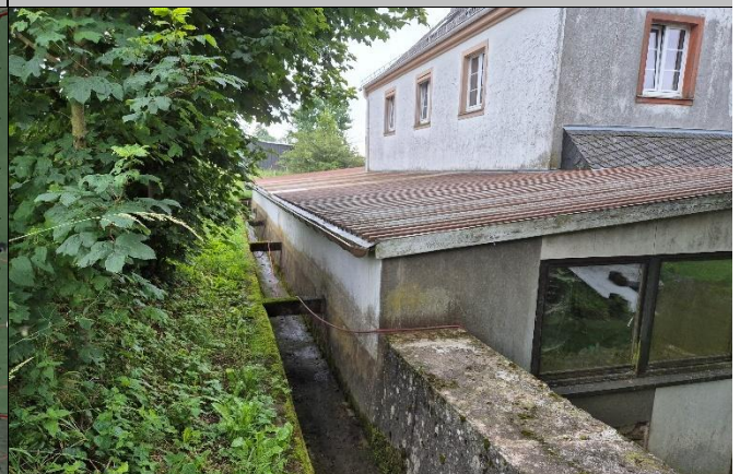
Betongraben als Objektschutz an der alten Schule
