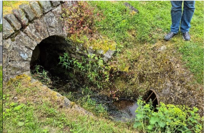
Auslass Bahndamm und Einlass Verrohrung: Birkenweg 12
