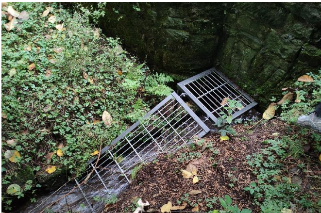
Einlassbauwerk auf dem Grundstücksbereich
