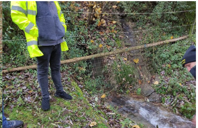
Auslass der Verrohrung Burgstraße/Bitburger Straße
