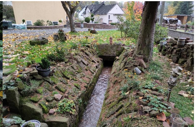
Beginn Verrohrung Neidenbach
