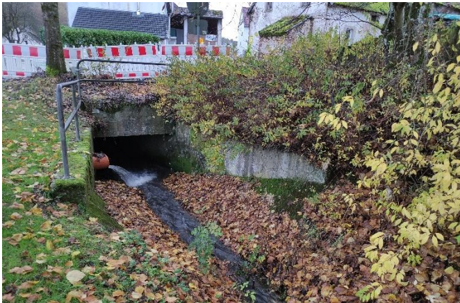
Einlassbereich mit Zulaufrohr vom „Alten Waschplatz“
