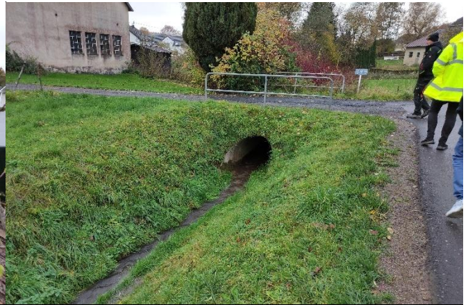
Einlassbauwerk „Im Brühl“ mit Überfahrt
