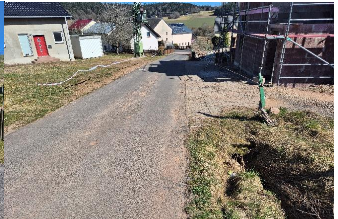
Verlauf des Seifenpfades in östliche Richtung
