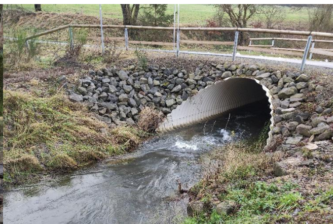
Durchlassbauwerk der Heltenbachermühle
