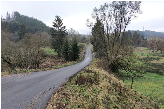
Blick in südliche Richtung auf das Bauwerk
