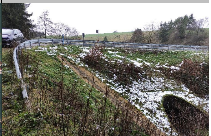
Auslassbauwerk der kreuzenden K102
