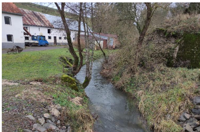
Bereich vor dem Durchlassbauwerk
