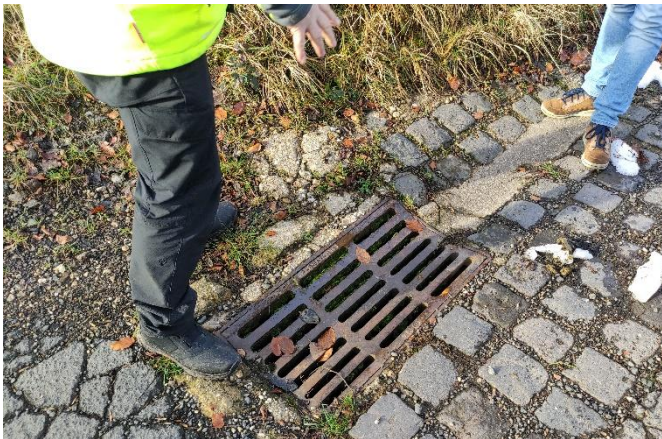
Einlassbauwerk „An den Buchen“
