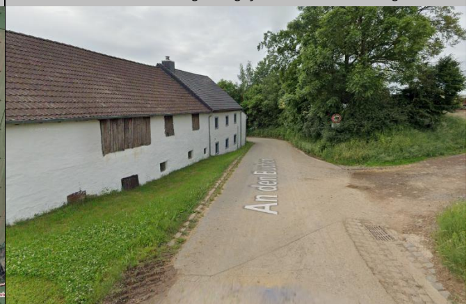
Blick in südliche Richtung mit gefährdeter Bebauung
