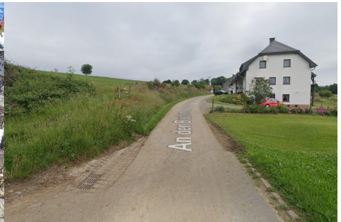
Blick in nördliche Richtung d. Str. „An den Buchen“
