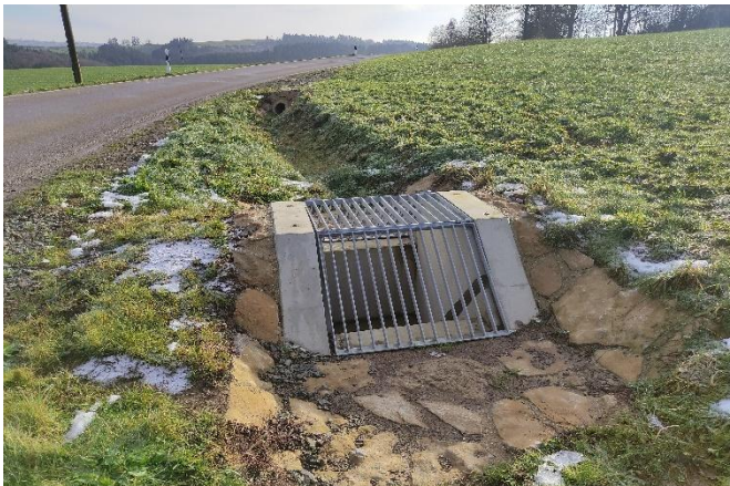
Einlassbauwerk an der Hauptstraße, Blickrichtung Süden
