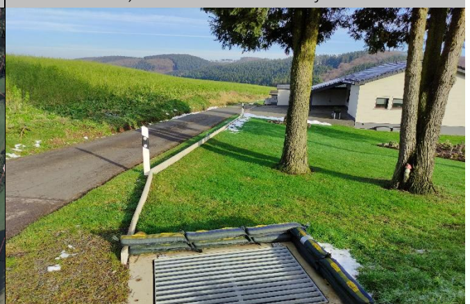
Einlassbauwerk, Randsteine sowie Einlaufschächte
