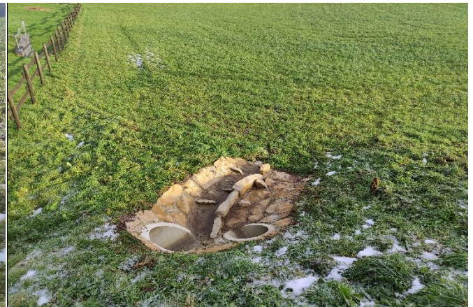
Auslass in Wiese beider Bauwerke
