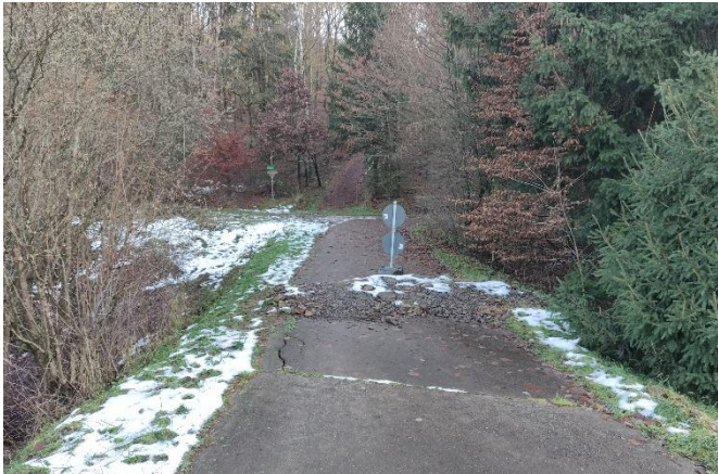
Brückenbauwerk über Ihrenbach
