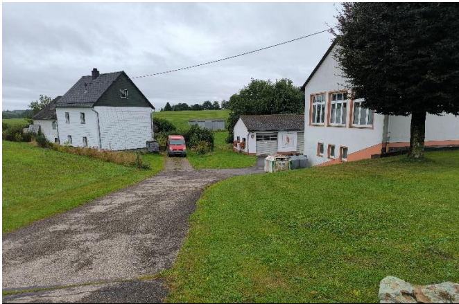
Zufahrt zum Bereich des Feuerhauses
