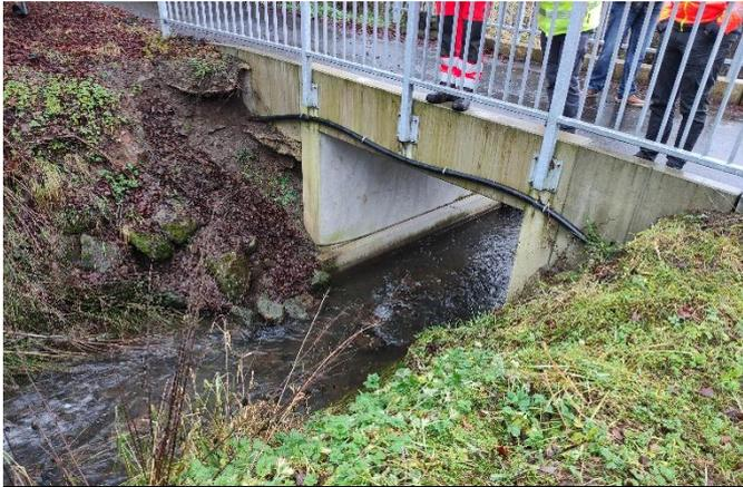
Blick auf das Brückenbauwerk mit marodem Fundament
