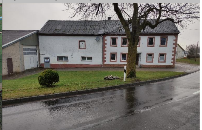
Gefährdetes Objekt im Fließbereich des Wassers
