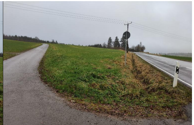
Blick entlang L1 in südwestliche Richtung
