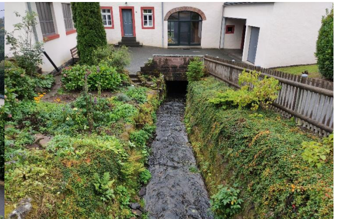
Aufnahme des Einlassbauwerkes unter dem Objekt
