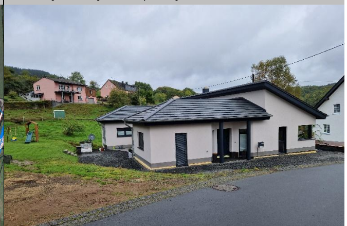
Blick auf das Objekt Hauptstraße 10
