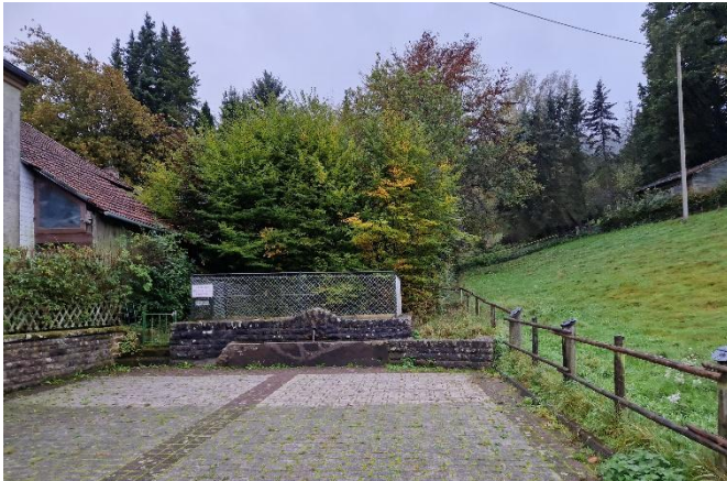
Blick auf das Löschwasserbecken
