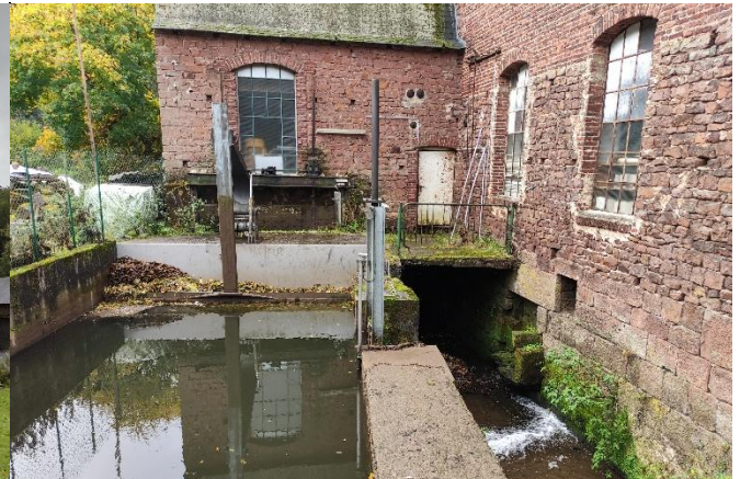
Mülhgraben am Fabrikgebäude
