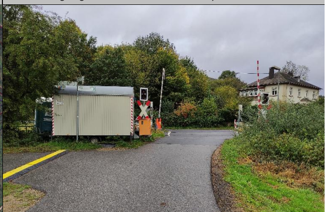
Bahnübergang zwischen L 24 und der Kyll
