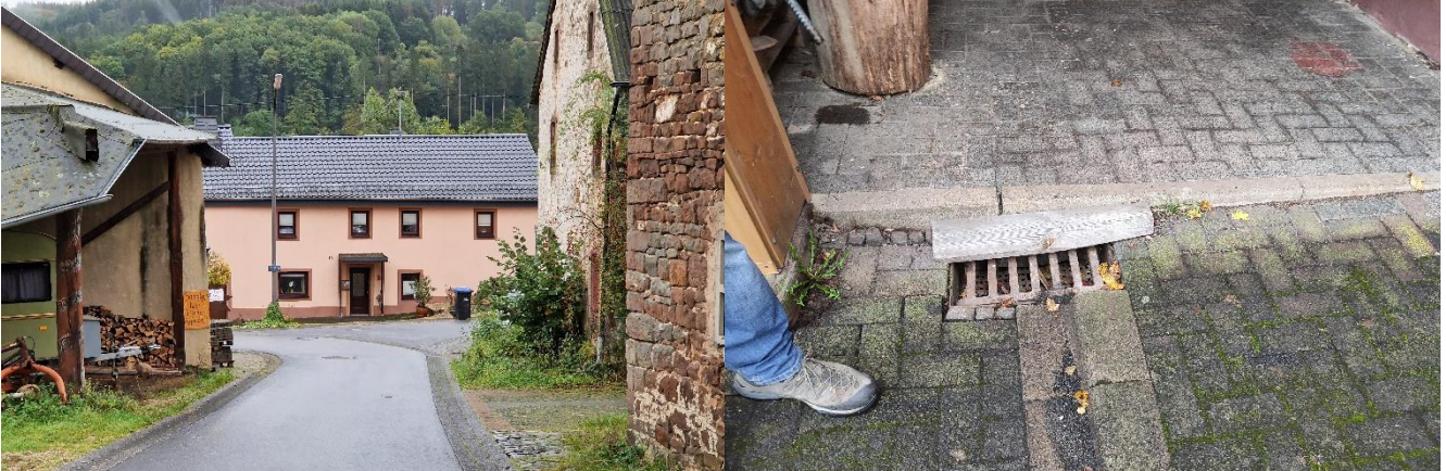
Blick auf Hauptstraße 13 als stark gefährdetes Objekt
