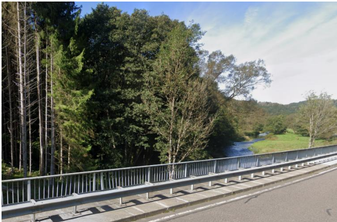
Blick von der L 24 auf die Kyll, Blick gegen die Fließrichtung
