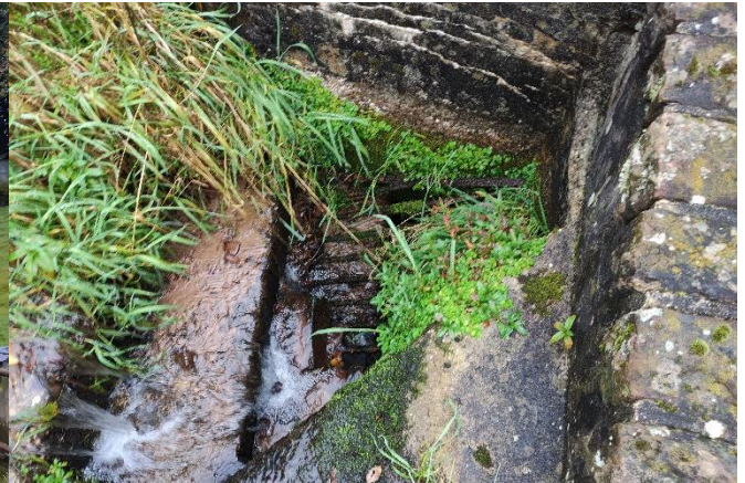
Einlassbauwerk am Löschwasserbecken
