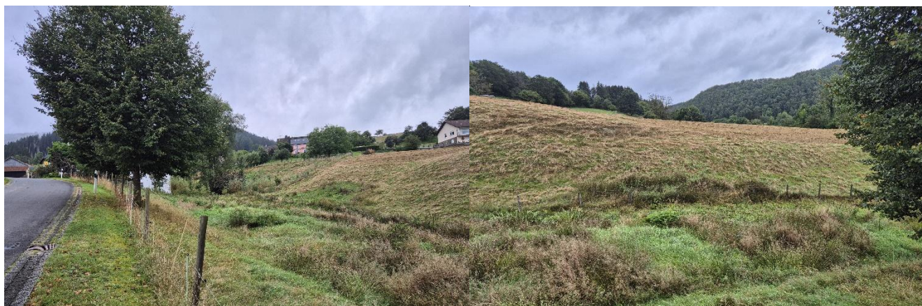
Regenrückhaltebecken mit Blick in westliche Richtung
