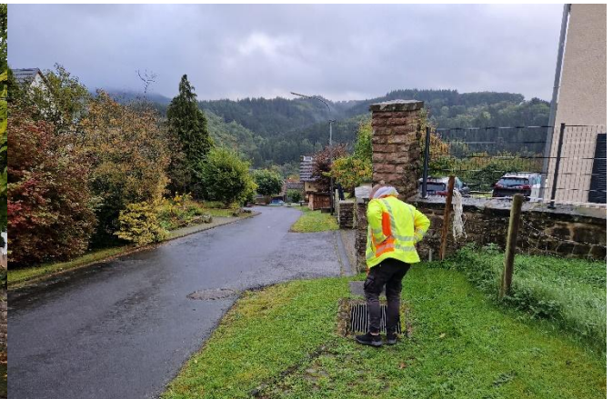
Niedriger gelegenes Einlassbauwerk
