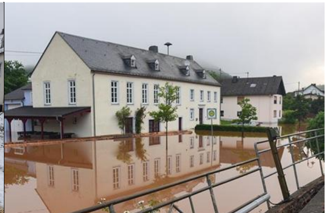
Überflutetes DGH und Feuerwehr-Gerätehaus
