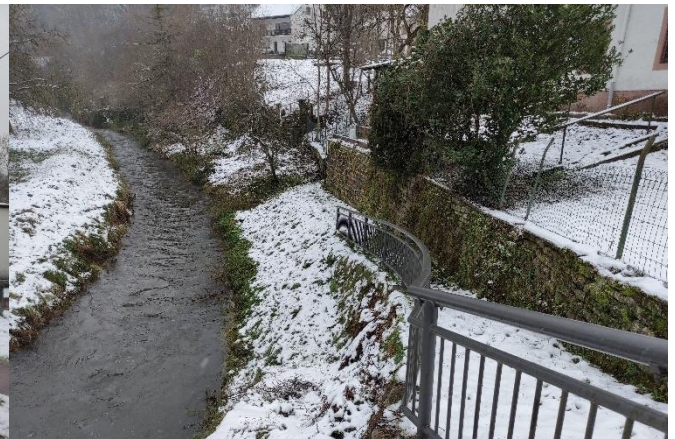
Abschlag in den Mühlengraben über Treppenbauwerk
