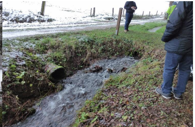
Durchlassbauwerk im Weg
