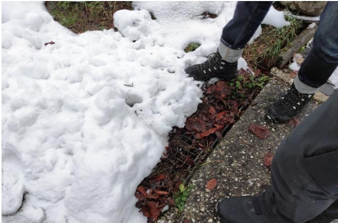
Blick auf das zugesetzte Einlassbauwerk
