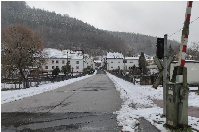
Blick in westliche Richtung über das Brückenbauwerk
