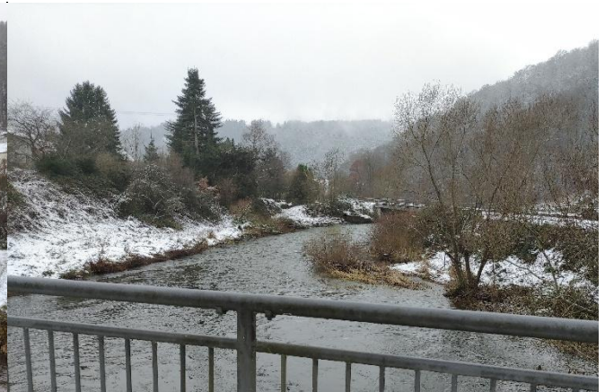
Kyll vor der Brücke der Hauptstraße (Blick in Fließrtg.)
