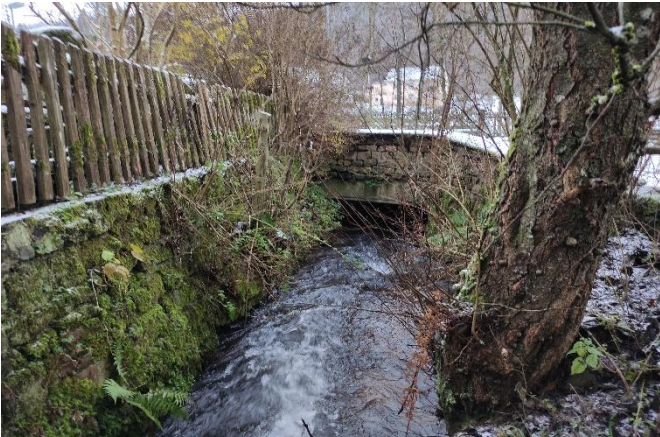
Blick auf unteres Durchlassbauwerk
