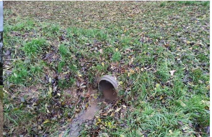
Durchlassbauwerk im Wegeseitengraben
