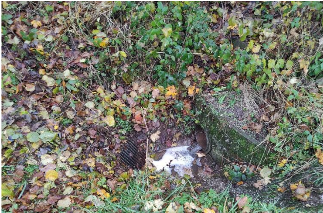
Einlassbauwerk am südlichen Ende
