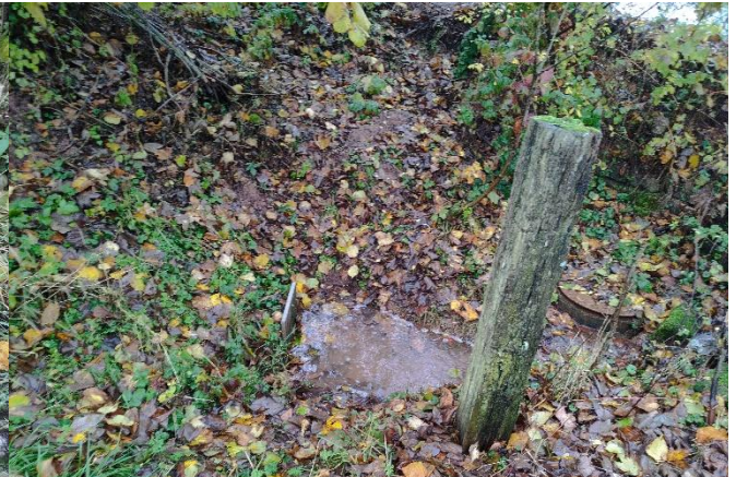
Einlassbauwerk am nördlichen Zufluss
