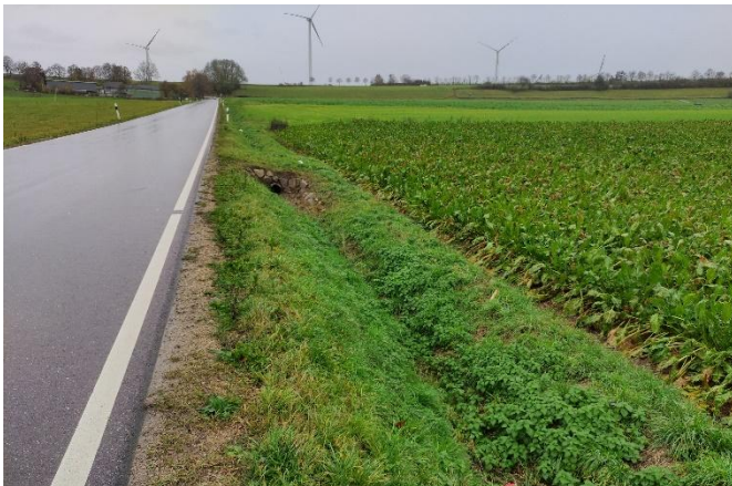
Verrohrung unter einer Feldzufahrt an der L34
