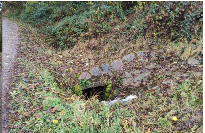
Aufnahme Einlassbauwerk im unteren Kurvenbereich
