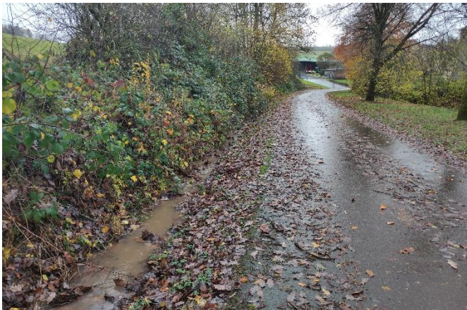
Hangseitiger Entwässerungsgraben in nördliche Richtung
