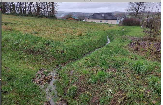
Privat angelegter Entwässerungsgraben
