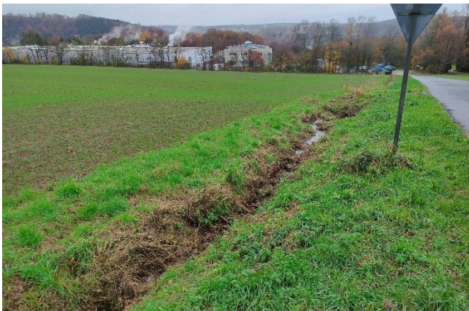
Wegeseitengraben entlang der Eifelwerkstraße
