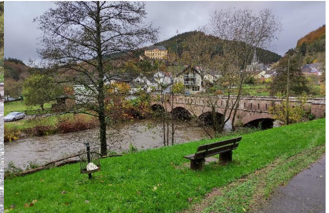
Kyllbrücke, Blick von der linken Kyllseite
