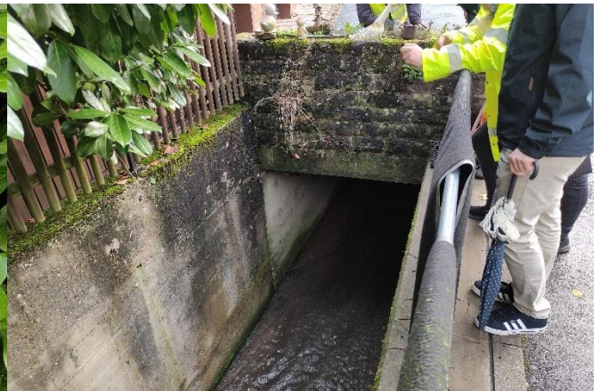
Einlass der Bachverrohrung
