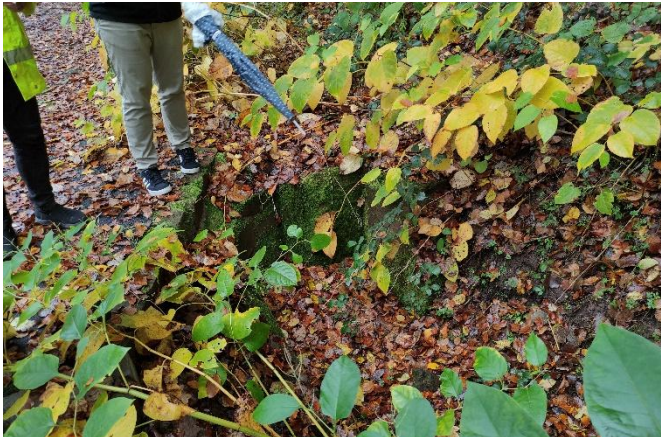
Beginn Verrohrung im Hang
