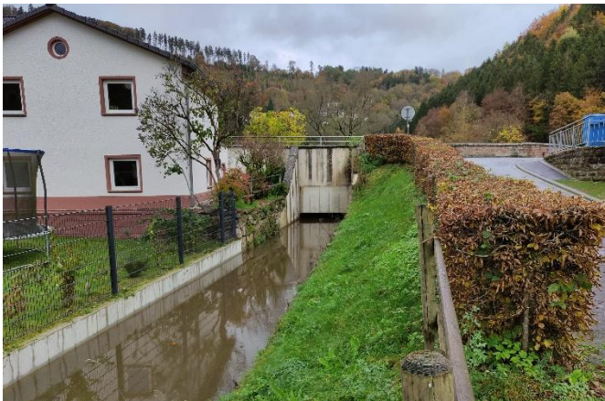
Blick auf Brückenbauwerk
