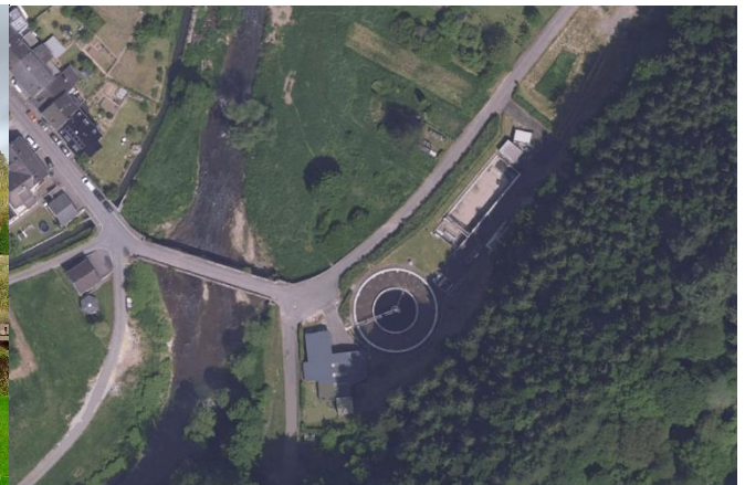
Kläranlage an der Kyll (Luftbild: Geoportal RLP)
