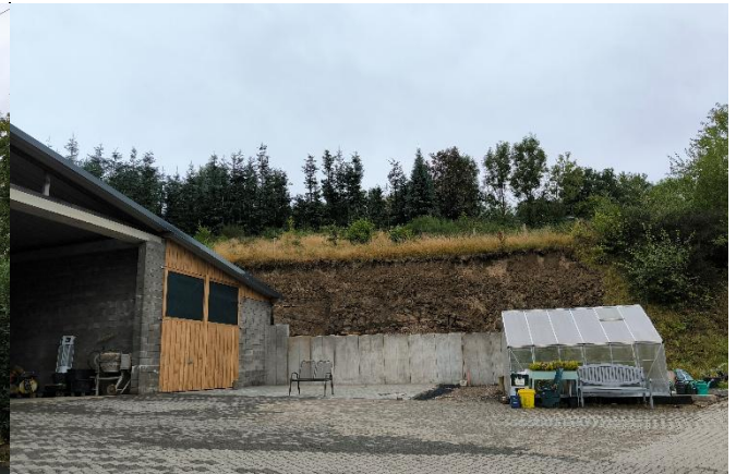
Eingeschnittener Hang im Bereich der Straße
