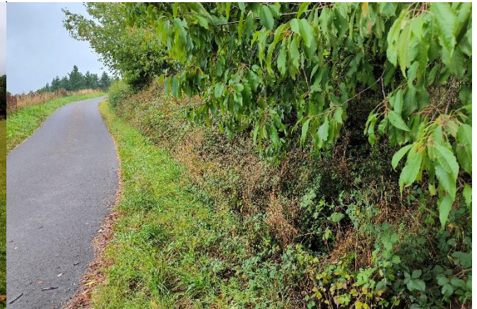
Hangseitiger Wegeseitengraben oberhalb der Bebauung
