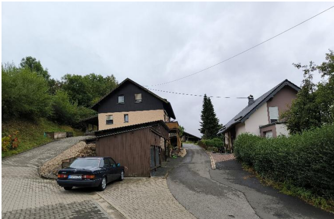
Bebauung an d. Straße mit Blickrichtung nach Süden
