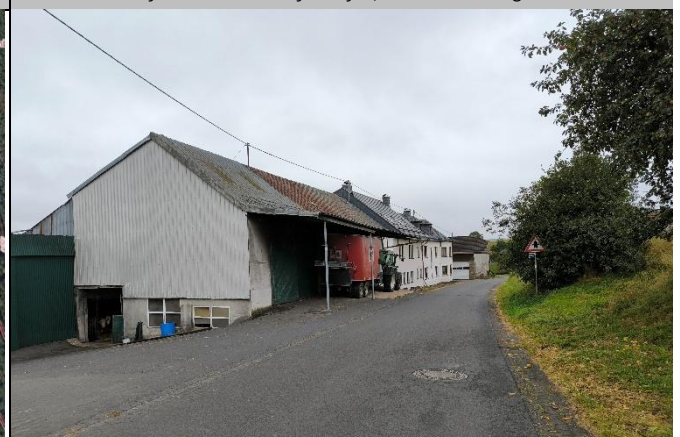
Bauliche Objekte in d. Dorfstraße, Blickrichtung Osten
