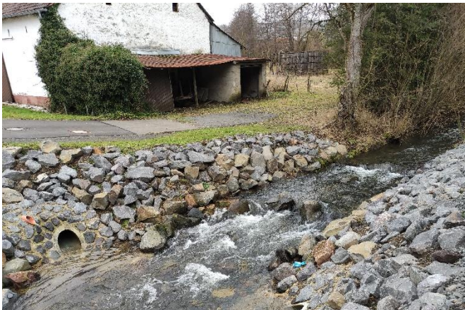
Vorlauf des Brückenbauwerkes mit sichtbarem Zulauf
