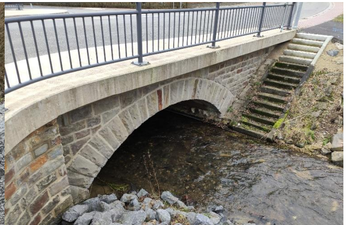
Durchlass des Brückenbauwerkes entlang d. Hauptstraße
