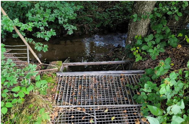
Einlassbereich des Bauwerkes
