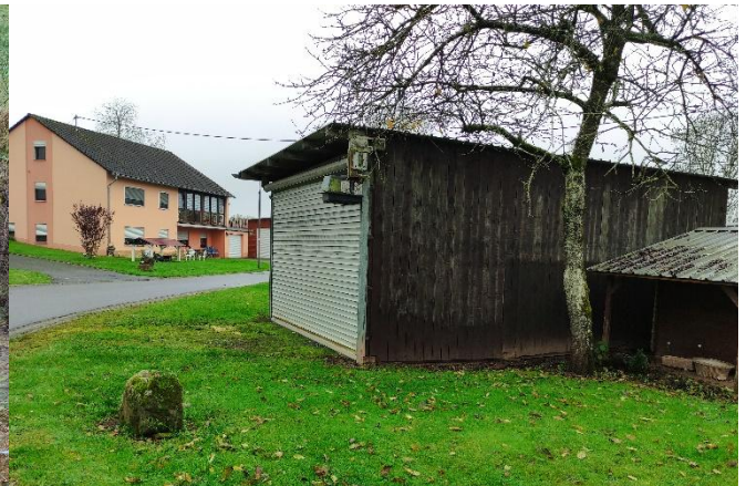
Gefährdete Objekte auf Privatgrundstück
