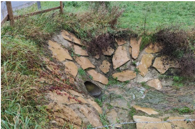
Beginn Verrohrung des namenlosen Gewässers
