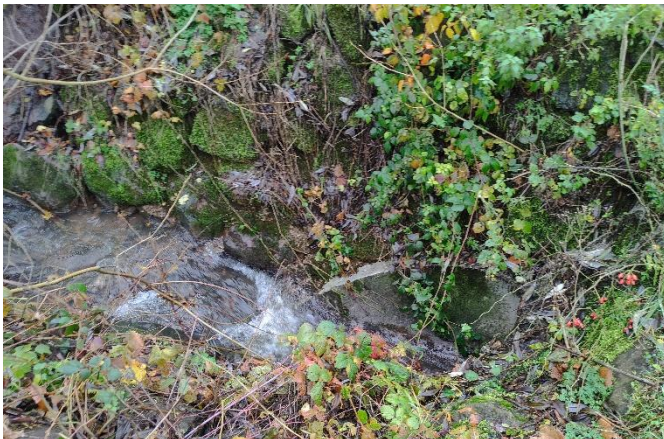
Einlassbauwerk, Beginn der Verrohrung a. d. Hauptstraße
