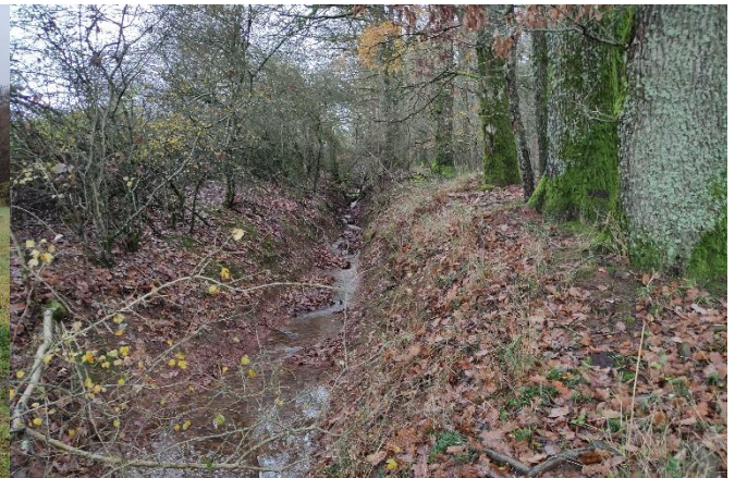
Entwässerungsgraben im Waldgebiet
