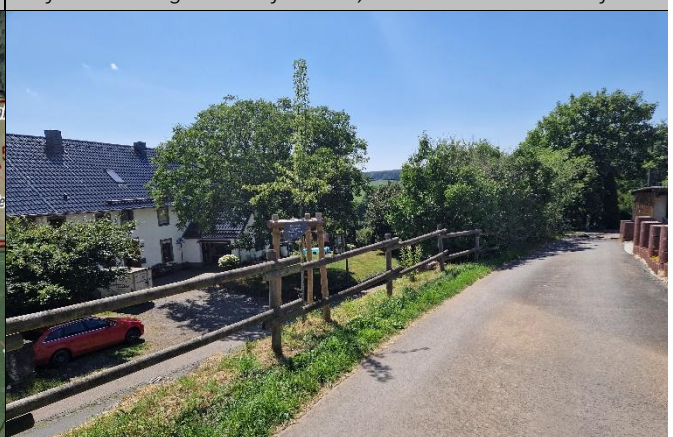
Abfluss entlang der Straße oben, links Desserather Straße
