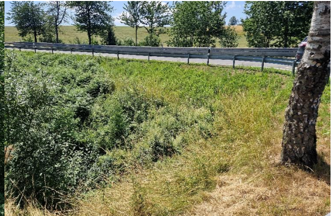
Auslassbereich unterhalb der B 257, Blick gg. Fließrichtung
