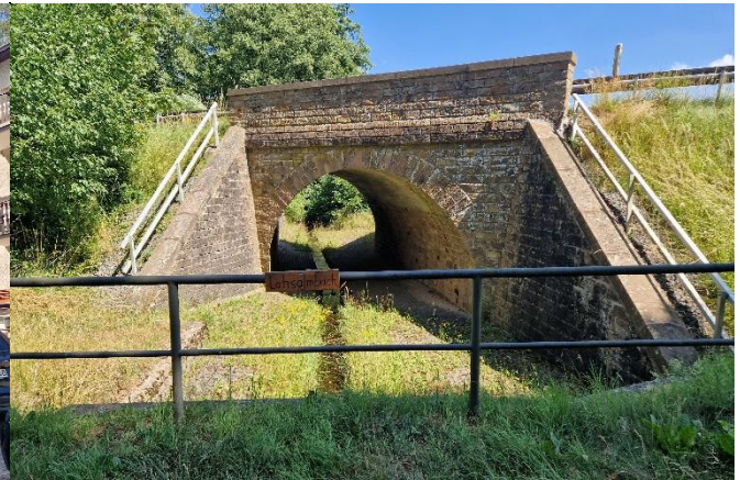
Blick vom Wededurchlass auf den Straßendurchlass
