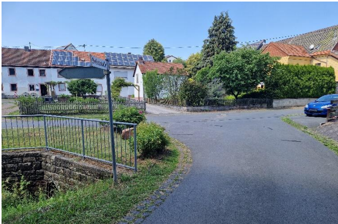
Blick auf die Kreuzung und den Auslass der Bachverrohrung
