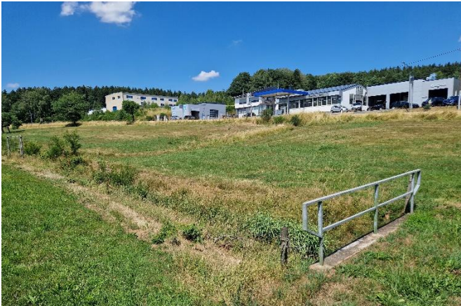
Blick vom Durchlass gegen die Fließrichtung
