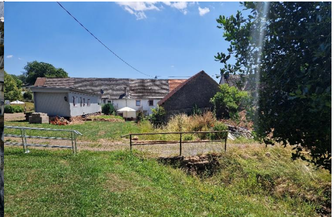
Private Zufahrt, im Hintergrund Gebäude am Bacheinlass
