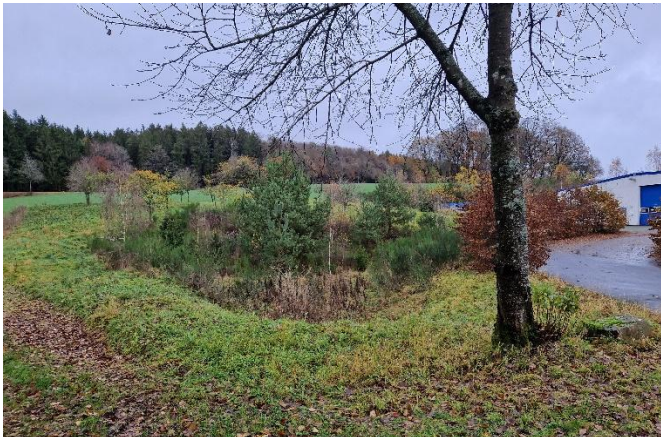
Privates Rückhaltebecken an der Densborner Straße
