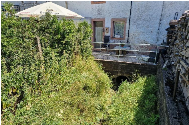
Einlass in die Bachverrohrung hinter dem Bebauungsriegel
