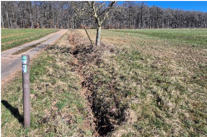
Graben in Verlängerung d. Baches von der B 257 kommend
