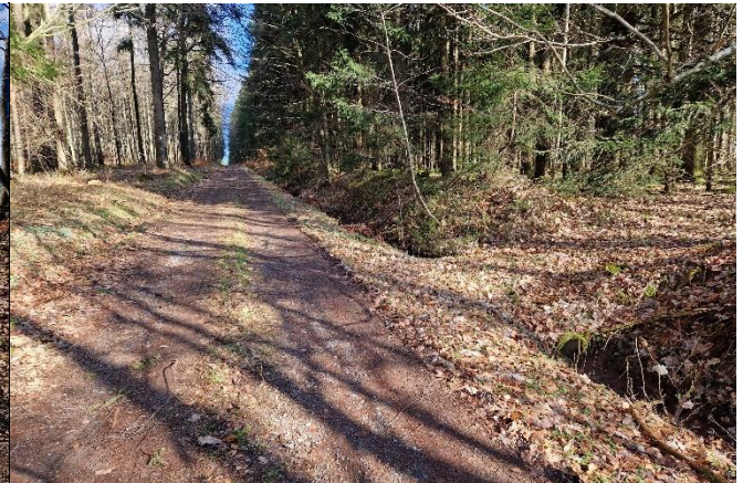
Weg und Graben entwässern Richtung B 257
