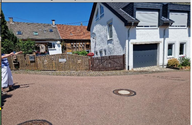
Bachverrohrung in Straße „Im Dümpel“
