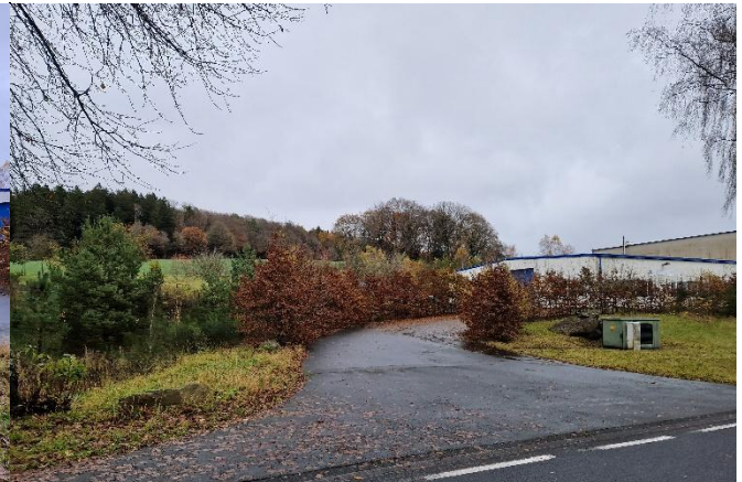
Zufahrt zum Betrieb: Rigole rückseitig des Gebäudes
