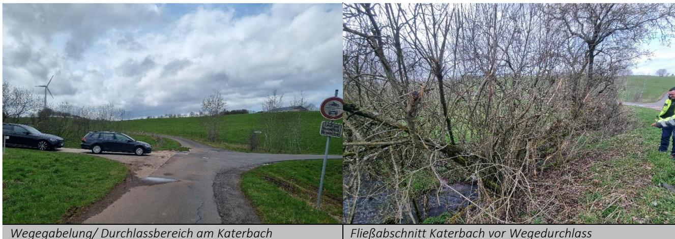
**Situation** Der Katerbach fließt nördlich der bebauten Ortslage dem Langbach zu. Durch Überlastung des hier befindlichen Durchlassbauwerks am Katerbach sind durch Hochwasser Schäden am Weg entstanden, auch weil der Durchlass nur unzureichend unterhalten war und es dadurch zu frühzeitigem Rückstau und einer Ausuferung sowie einem Überlaufen über den Durchlass kam.
