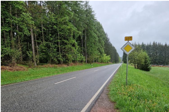
B 407 zwischen Forst (links) und Ortslage (rechts)
