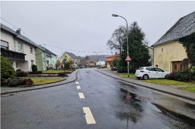
Gefährdeter Bereich der Hauptstraße, Blick nach Osten
