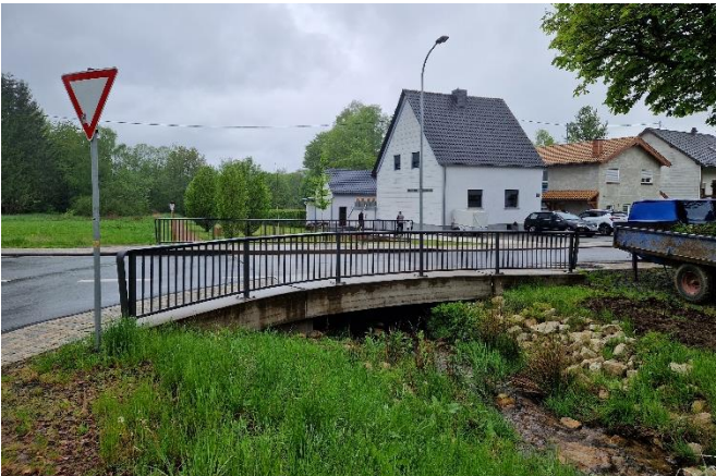
Durchlass Hauptstraße in Fließrichtung
