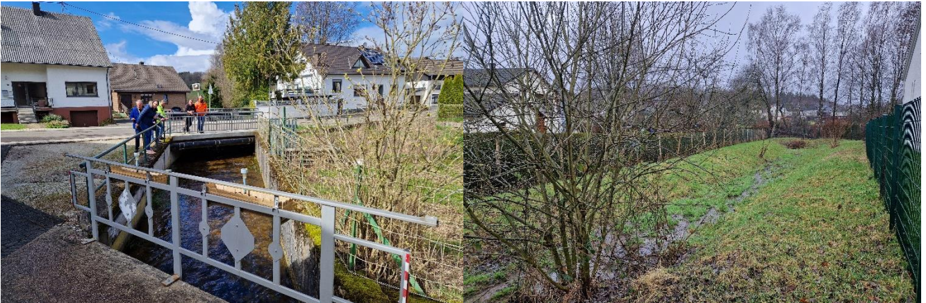
Brücke Hauptstraße (Hintergrund)
