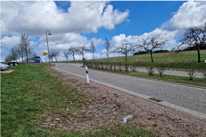
Einlass rechts, Blickrichtung außerorts
