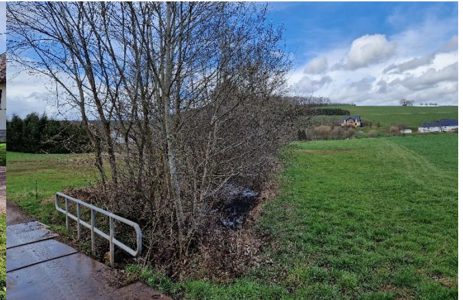
Winkelbach: Auslassbereich am Wegedurchlass
