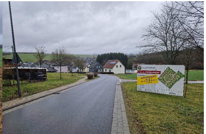
K 70, Blick zur Ortslage, Abflussweg bei Überlastung
