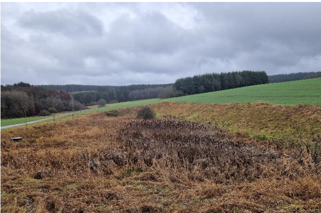
Unterhaltungszustand des Beckens an der K 70
