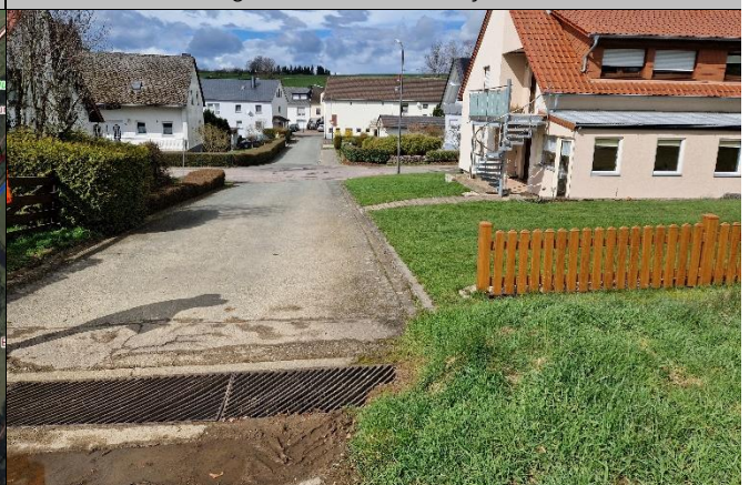
Querrinne am Weg zwischen Schulstraße 19 und 21
