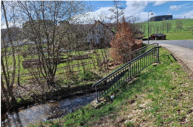
Burkelsbach-Durchlass der K 68 (Zerfer Straße)
