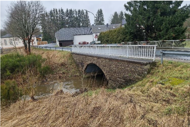
Durchlass Bahnhofstraße (K 71), Blick gg. Fließrichtung
