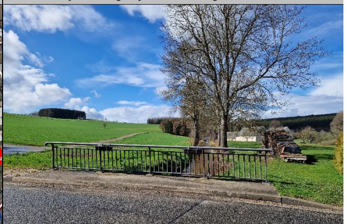
Blick in Fließrichtung auf den Mühlengraben
