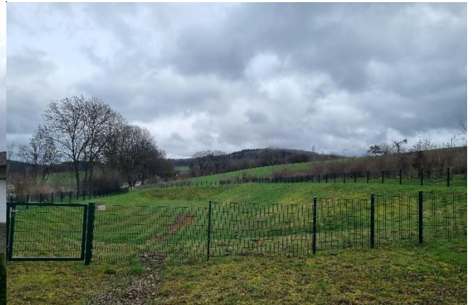
Rückhaltebecken des Neubaugebietes „Zum Sonnenhang“
