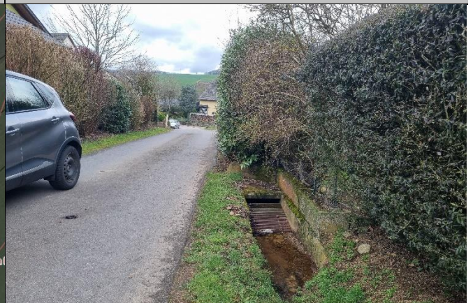
Einlassbauwerk oberhalb der Manderner Straße
