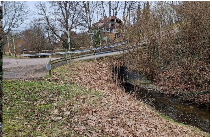
Durchlass Poststraße/ Deeswiese (Blick in Fließrichtung)
