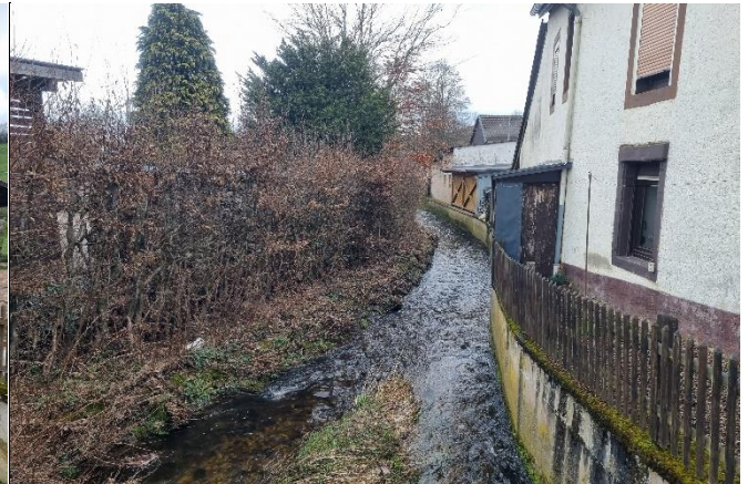
Fließabschnitt im Auslassbereich der Brücke
