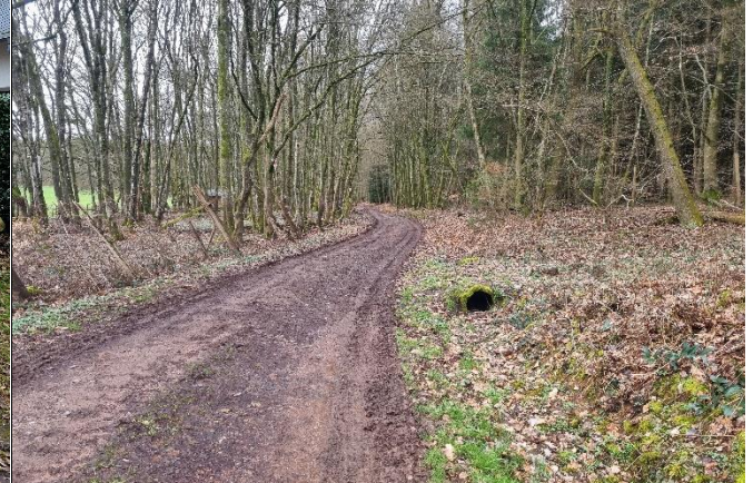
Blick ins Außengebiet, wegegseitige Entwässerung
