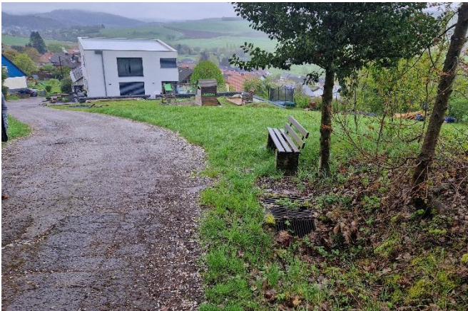
Nicht optimal funktionsfähiges Einlassbauwerk rechtsseitig
