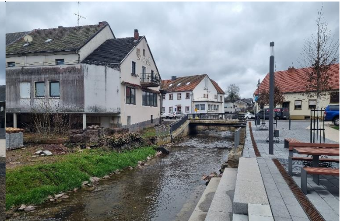
Blick von der Fußgängerbrücke zur Brücke Trierer Straße
