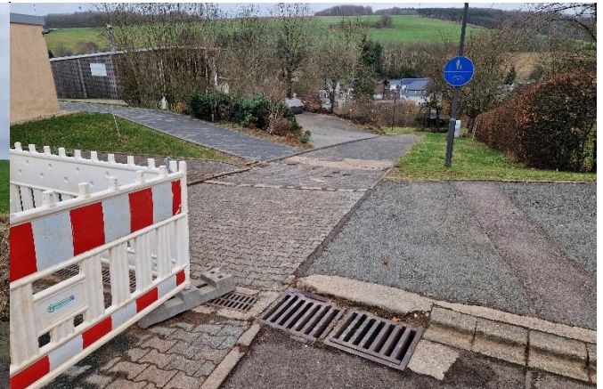
Potenzieller Abflussweg entlang der Schule zur Poststraße
