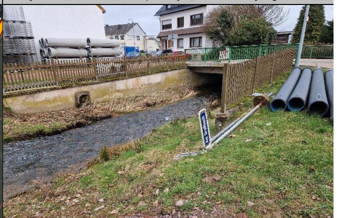
Straßendurchlass der Hauptstraße, Blick in Fließrtg.
