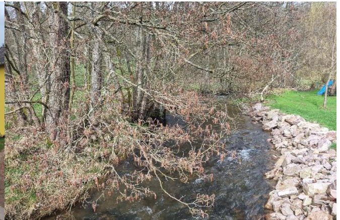
Uferbefestigung im Zulauf zur Fußgängerbrücke
