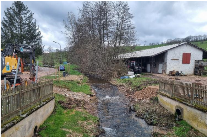
Fließabschnitt vor Brückendurchlass an der Hauptstraße
