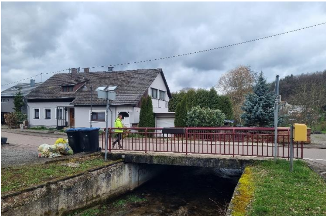
Brückendurchlass an der Manderner Straße
