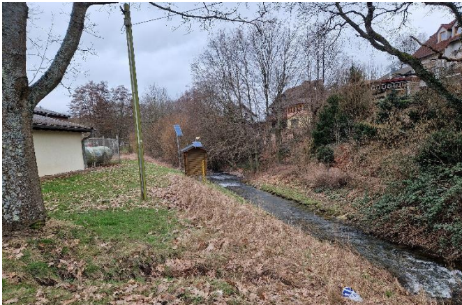
Blick in Fließrichtung des Großbaches, links Gastank
