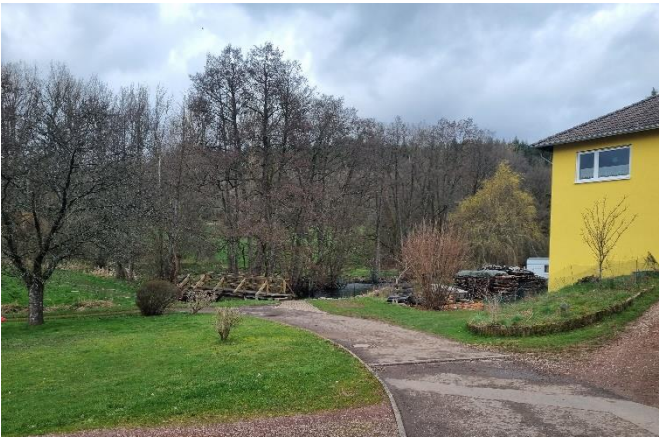
Manderner Straße, Fußgängerbrücke an der Ruwer
