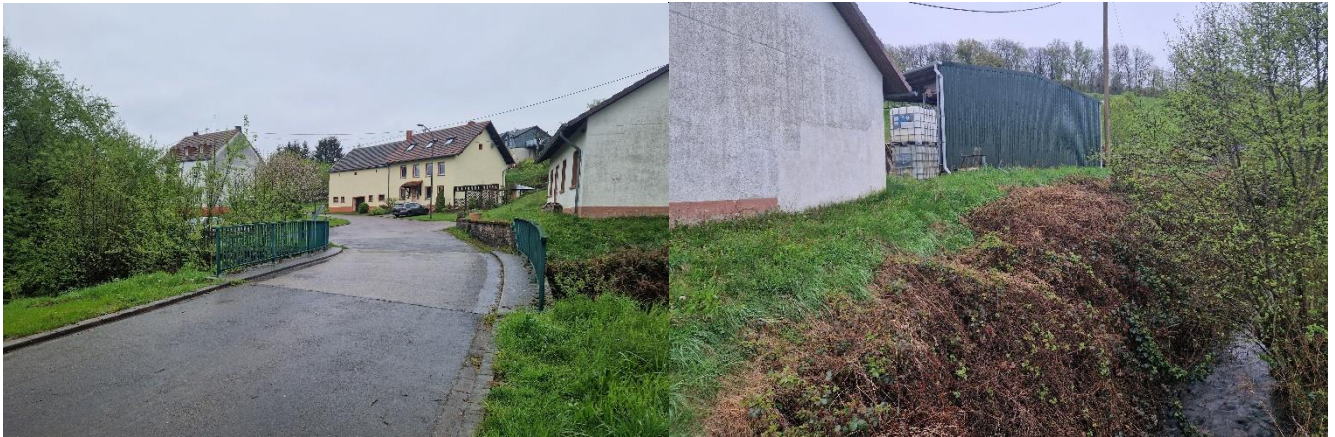
Blick auf den Durchlass des Waldbaches
