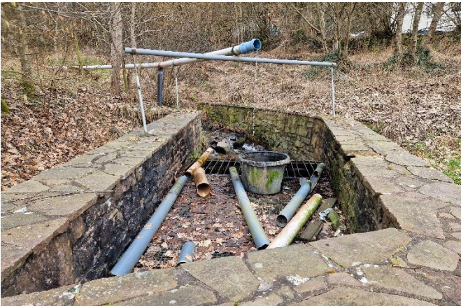
Einlassbereich, oberhalb der Bebauung
