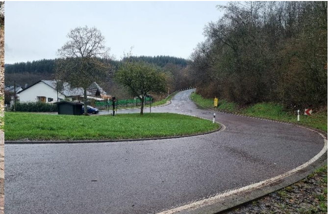
abflusskritischer Str. abschnitt, unterhalb des Einlassbauwerks
