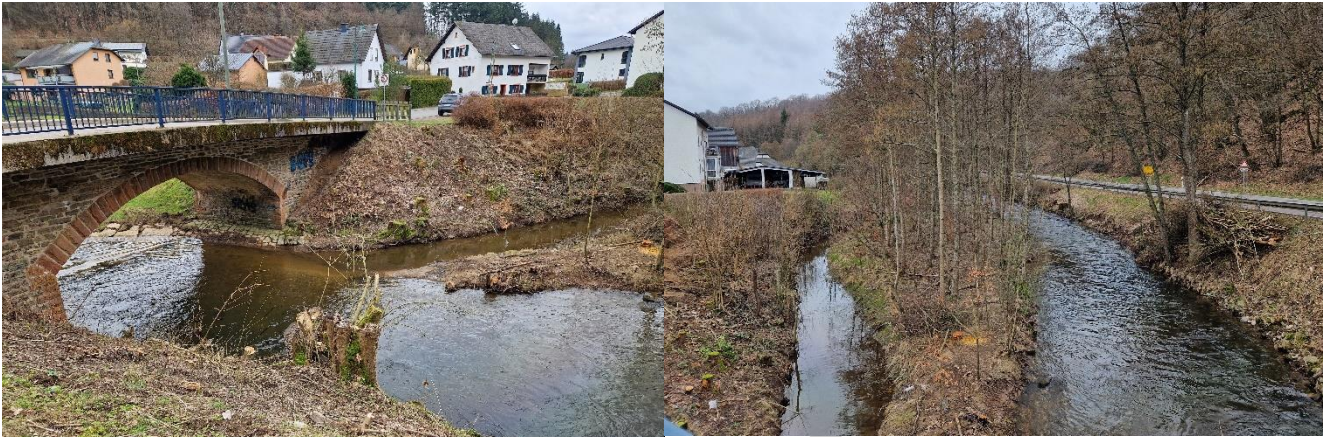
Mühlgraben und Ruwer vor der Brücke „Mühlendriesch“
