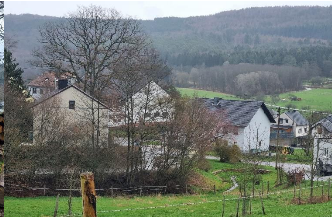
Innerörtlicher Fließabschnitt vor Einlass in die Verrohrung
