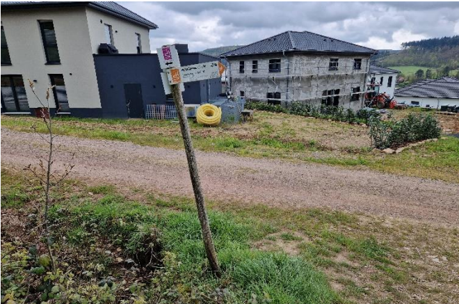
Einlass der Außengebietsentwässerung (vorne links)
