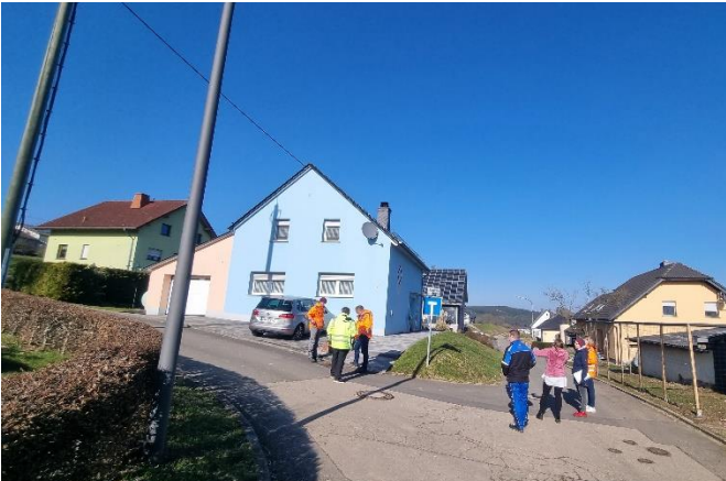
Ringstraße, Abschnitt Ringstraße 2
