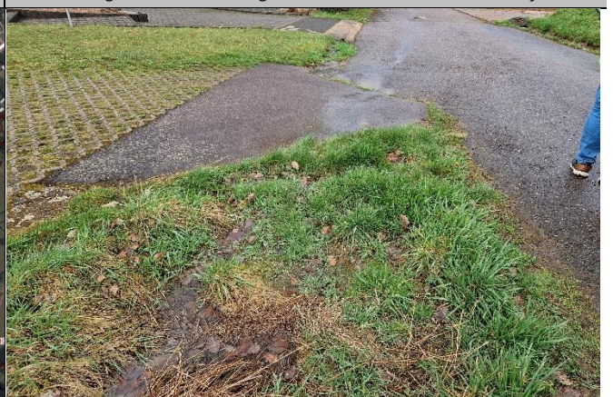
Linksseitige Entwässerung im Bereich Scheidener Straße 10
