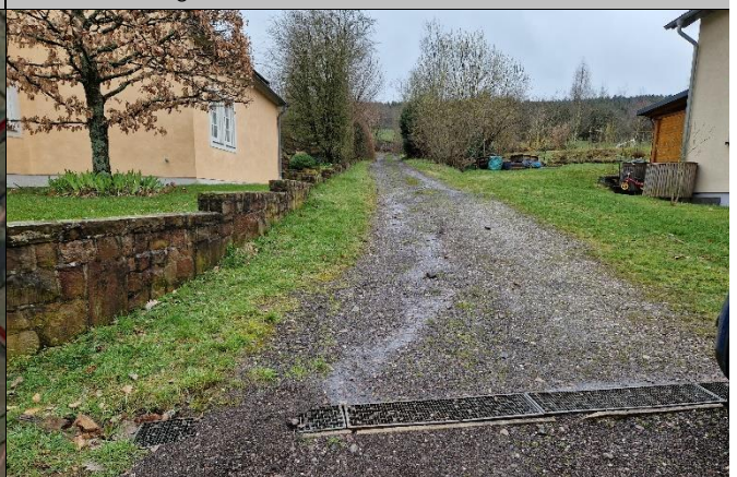
Rinne am Weg unterhalb des Einlassbauwerks
