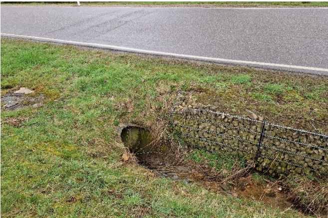
Entwässerung der K 139 vor der Ortslage
