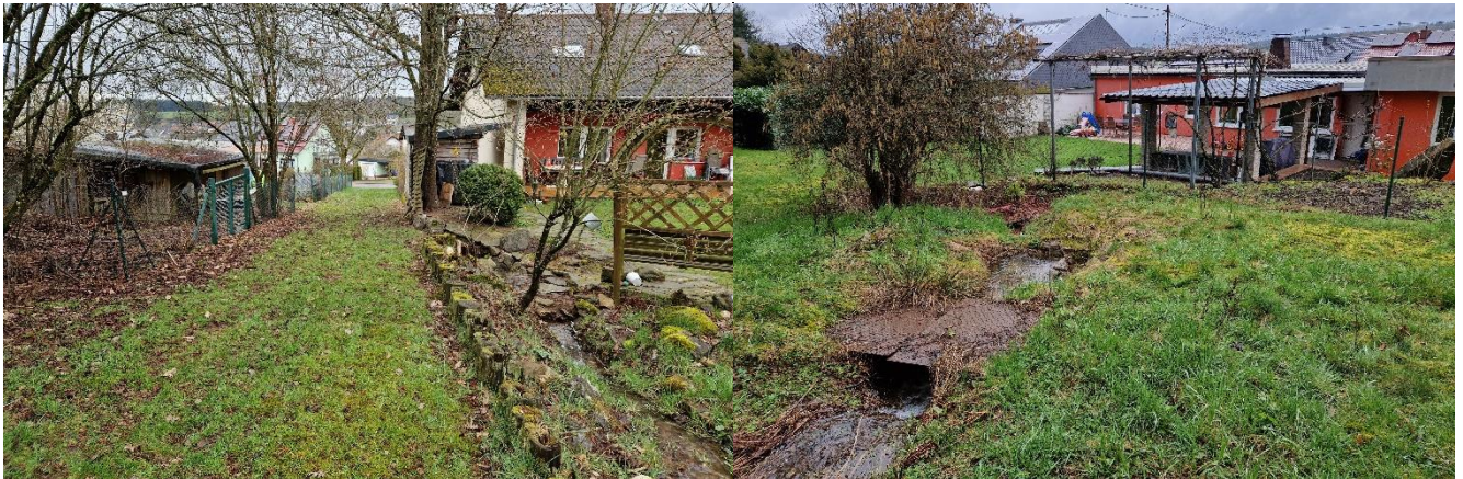
Gefasste Entwässerung auf dem Grundstück Nr. 16 (rechts)
