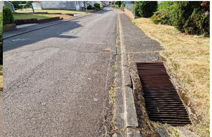
Einlassbauwerk rechtsseitig, Blick in die Ortslage
