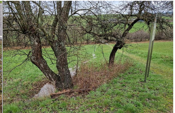
Auslass im Flurbereich „Bruchwiese“ zum Altbach
