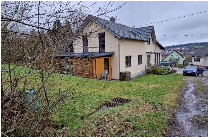
Einlass links des Weges, Blick zur Scheidener Str. (16A)
