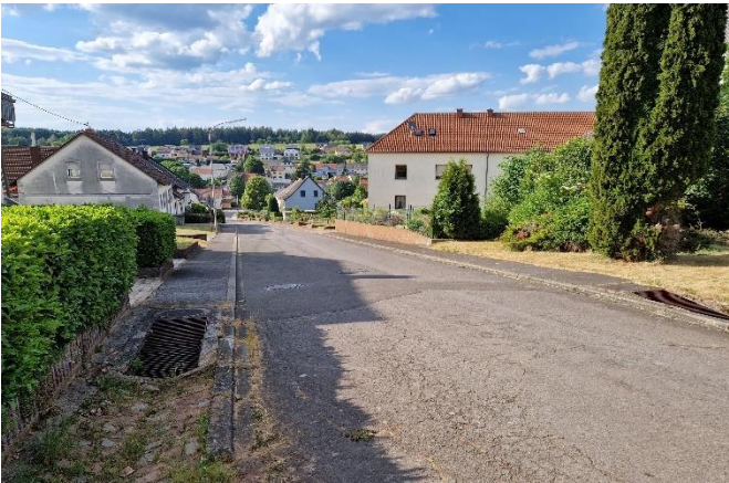
Einlassbauwerk linksseitig, Blick in die Ortslage
