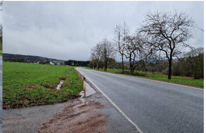
Graben an der K 139 Richtung Ortslage
