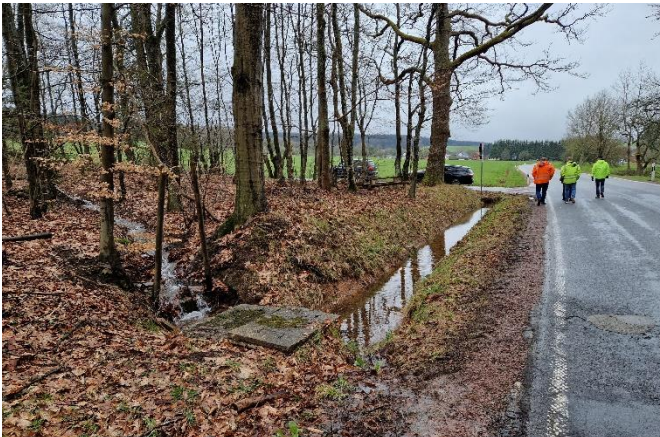
Entwässerungseinrichtungen an der K 139 am Wald
