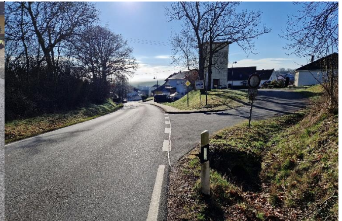
Rohrdurchlass an der Einmündung Gartenstraße
