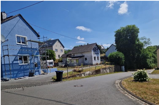
Blick von der Kirchstraße in die Siebenbachstraße
