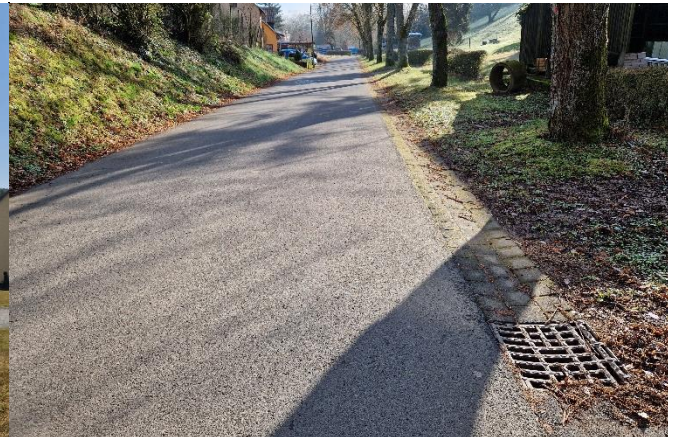
Entwässerung in der Siebenbachstraße, Bereich Nr. 8-10
