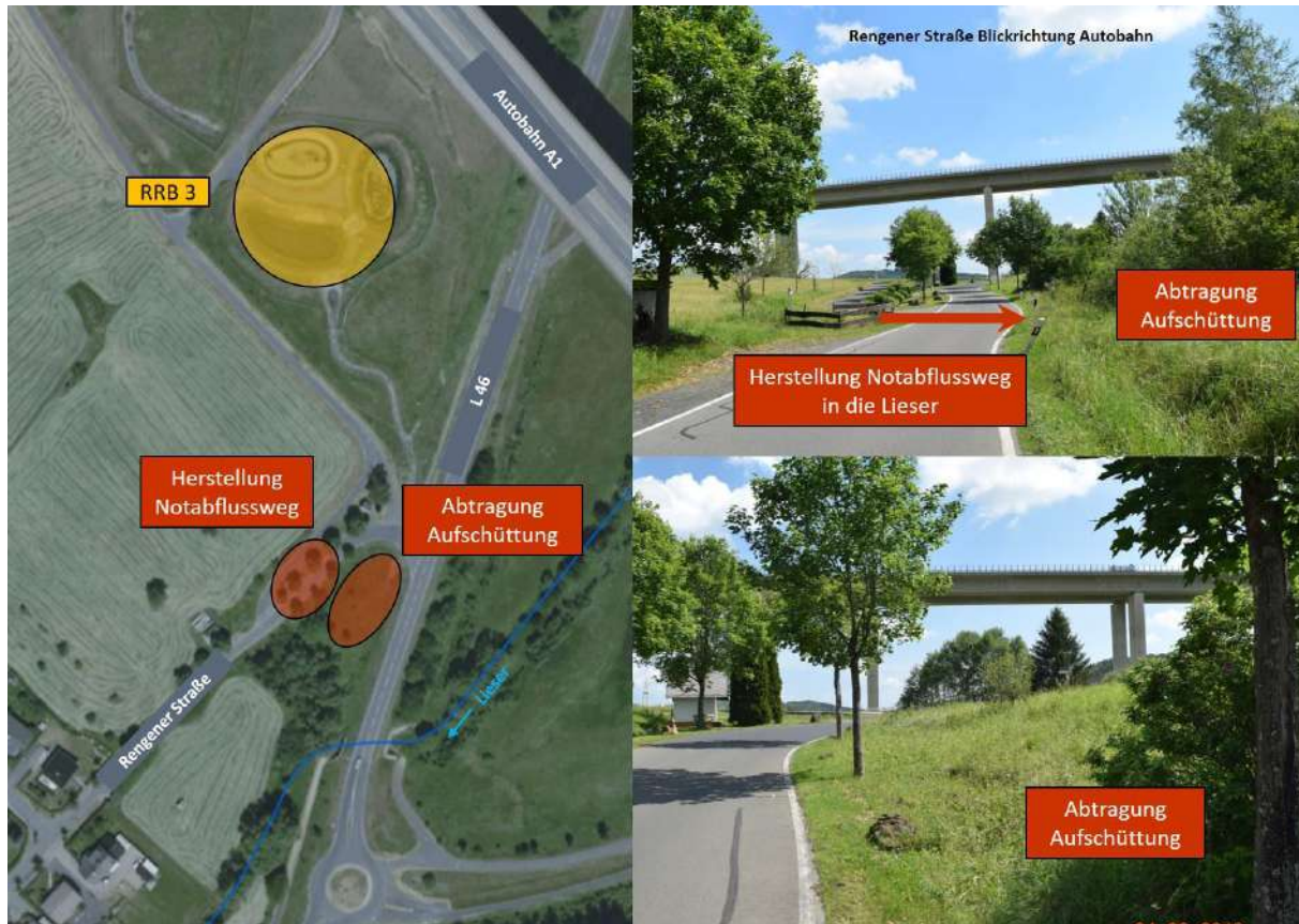
Abb. 19: Rengener Straße Ortseingang Nord
