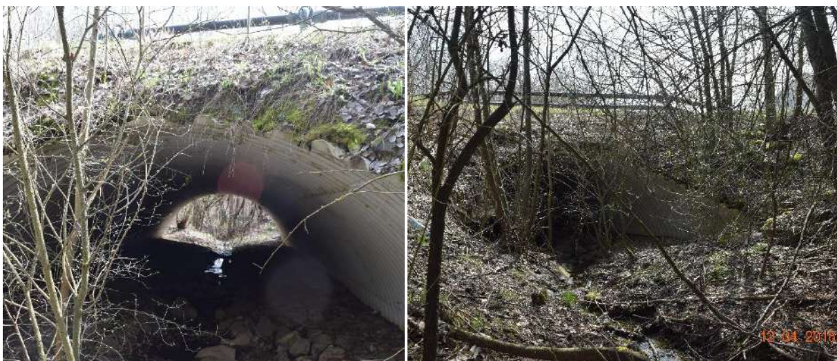
Abb. 18: Nadelwaldgraben am Durchlass Konrad-Zuse-Straße (in Fließrichtung)
